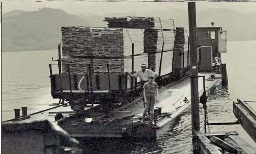
Da kommt die Platte des Sägewerks Häupl am 30. August 1966 zum letzten Mal mit drei beladenen Güterwagen über den Attersee, um die Wagen am Fähranschluss der Attergaubahn (760-mm-Spur) anzulanden. Die Simplizität von Fähre und Fährhafen ist unübertroffen. Nachdem der Triebwagen die Wagen von der Fähre gezogen hat (Bild unten), schaut diese wesentlich weiter aus dem Wasser heraus. *Fotos: Peter Schmied, Archiv Stern & Hafferl*
