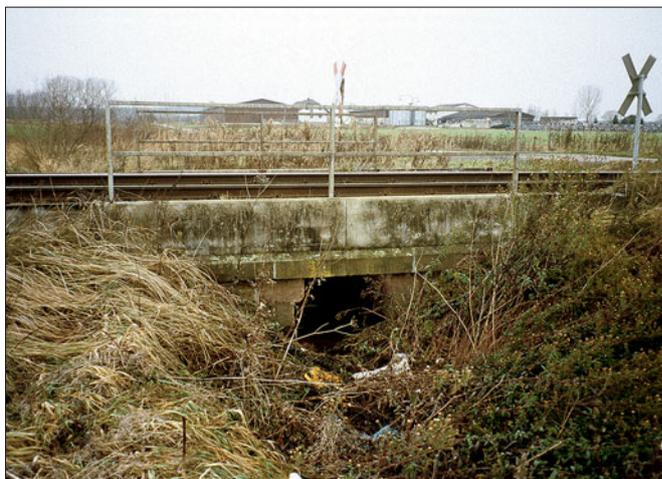
Auch dieser Durchlass besteht aus Beton, erscheint jedoch weniger durchgestaltet. Überdies hat die ständige Feuchtigkeit deutliche Spuren in Gestalt von Moosen und Flechten hinterlassen.
