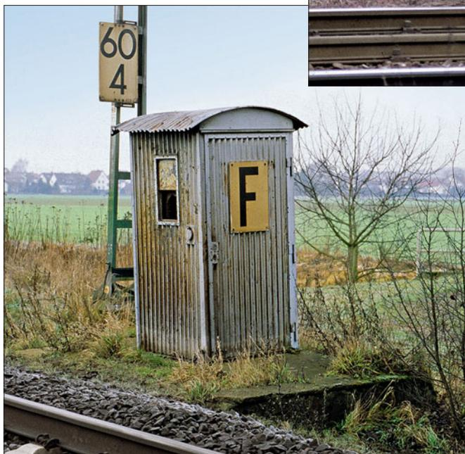
Auf einem durchgehenden Betonfundament steht diese Wellblechbude als Streckenfernsprecher – schon leicht geneigt – an einer zweigleisigen Hauptstrecke. Das Wellblech zeigt deutliche Spuren der Verwitterung, das F-Schild ist bereits stark vergilbt.
