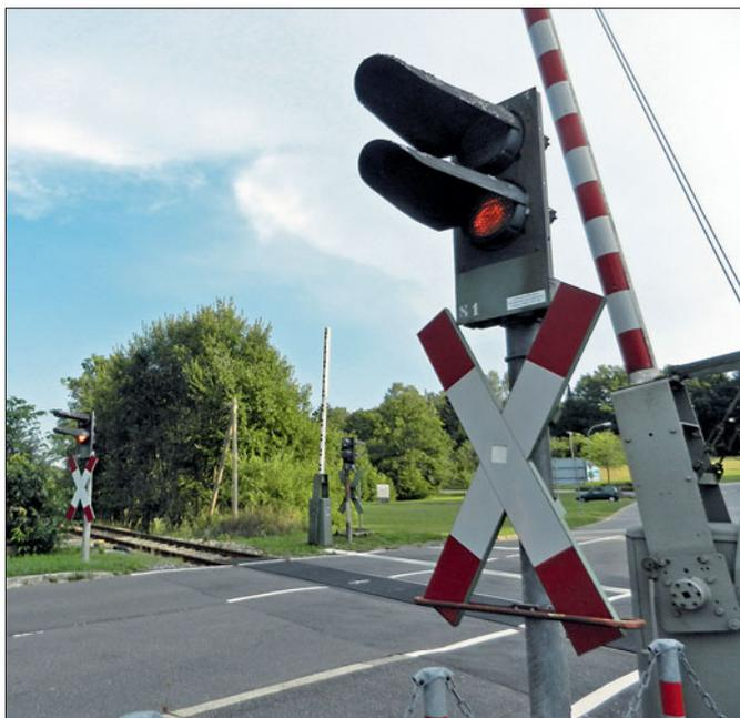
Die Gelbphasen von Vorbild und Modell im direkten Vergleich: Nach einer Gelbphase von etwa drei bis fünf Sekunden erscheint das rote Licht auf der Ampel. Nach weiteren sechs Sekunden beginnt der
