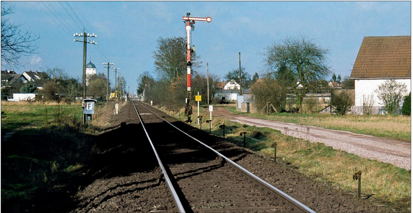
Auf der Odenwaldstrecke bei Seligenstadt stand der zum Einfahrtsignal gehörende Signalfernsprecher auf der gegenüberliegenden Seite des Gleises. Dies hatte offensichtlich den Grund, dass auf der Signalseite die Seilzüge für das Vorsignal verliefen und man keine Stolperfallen installieren wollte. Rechts: Die Fernsprecherkästen von Weinert aus Messing bilden die alte Bauform nach. Man muss sie lackieren, vom Gussast abtrennen und mit dem „F“-Schiebebild versehen.
