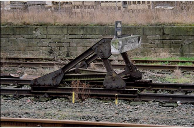
Der klassische Prellbock der sog. Einheitsbauart: Dickere I-Profile sind über Knotenblechen verschraubt und V-förmig versteift. Die Bremsleistung resultiert aus den mit den Schienen über die ganze Länge verbundenen und am Ende verschraubten Aufsatzprofilen.
