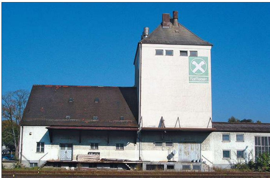
In Furth im Wald beherrscht der nahezu fensterlose Siloturm den dortigen Landhandel. Da keine weiteren externen Silos vorhanden sind, befinden sich wohl die gesamten Lagerkapazitäten im Inneren des Rechteckturms. Dass hier viel Getreide umgeschlagen wird, zeigen auch die vielen großen Entlüftungsöffnungen auf dem Dach.
