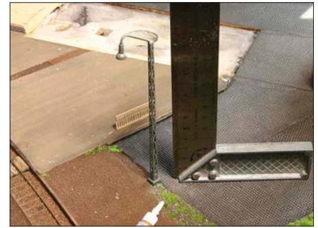
Vor dem endgültigen Festkleben prüft man durch sorgfältiges Ausrichten der Laternen einen senkrechten Stand des Mastes.
