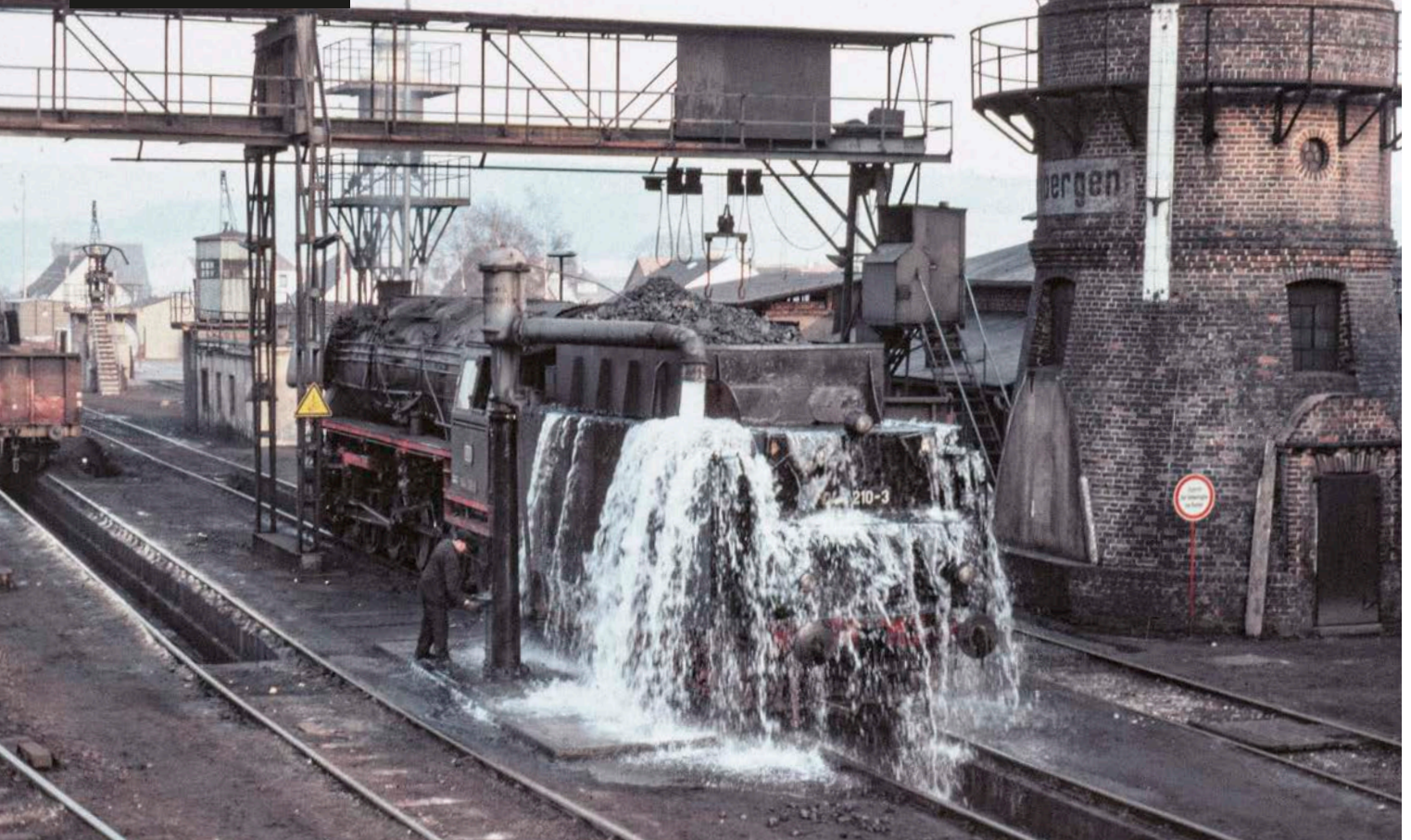
Oben: Auf dem Gleis 73 wird Wasser genommen. Damit der Schlackenwagen dieses Gleis nicht allzu sehr „blockierte“, wurde der Wasserturm unten abgemauert. So konnte Gleis 74 zum Abstellen eines Schlackenwagens verlegt werden. Nach dem Entschlacken und Wassernehmen wurde die Lok – wenn keine Fristarbeiten anlagen – zumeist in den Lokschuppen gefahren und im Ruhefeuer abgestellt. Foto: Bernard Huguenin
