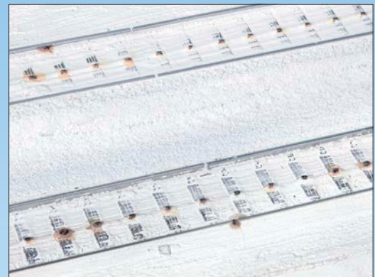
Die als Schneefläche aufgetragene Gipsschicht ist durch fehlenden Tiefengrund offenporig geblieben und hat durch Wasseraufnahme bei den Pukos zu Rost geführt.
