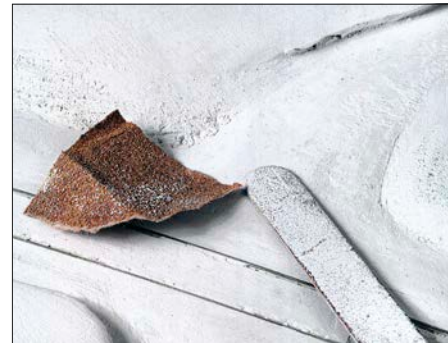
Mit Schleifpapier unterschiedlicher Körnung erzielt man eine glatte Oberfläche als Basis.
