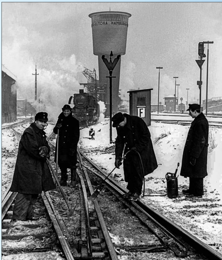
Die Zufahrt zum Bw Hamburg Altona darf auf keinen Fall vereisen. Mit einem Gasbrenner lässt sich die Kreuzungsweiche im Zungenbereich schnell und effektiv auftauen.
