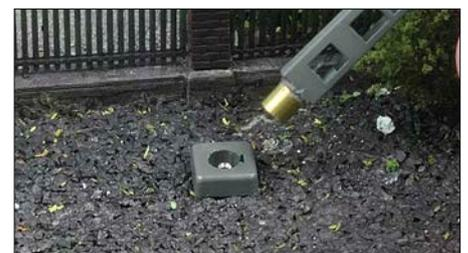
Leuchten mit Kontaktstecksockeln können bei anstehenden Bau- und Reinigungsmaßnahmen immer wieder leicht entfernt werden.
