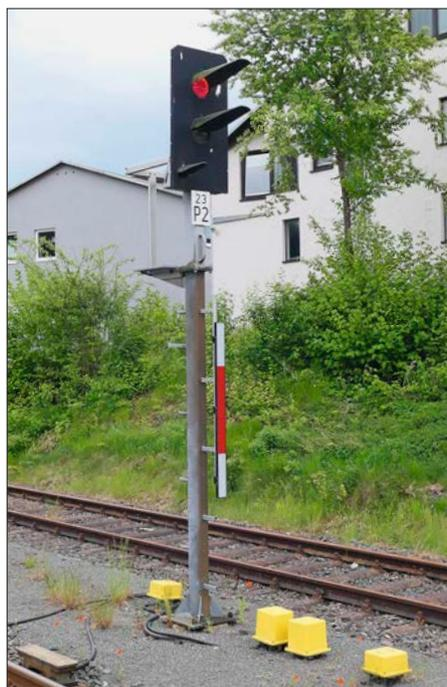
Kombinationssignale an den Ausfahrten sichern den Zugverkehr im Bahnhof in Willingen.
