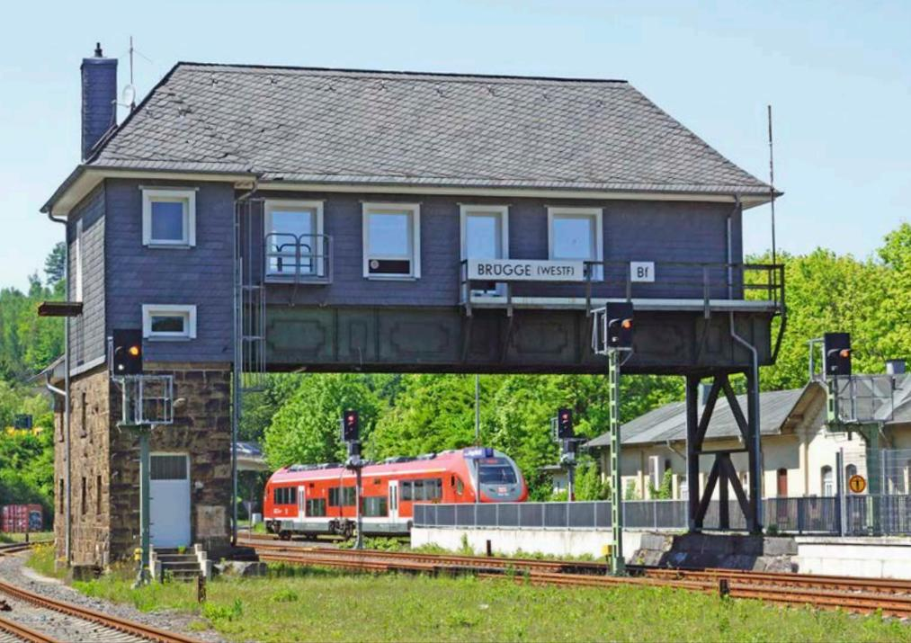
Im Bahnhof in Lüdenscheid-Brügge sind Ks-Ausfahrtsignale aufgestellt. Interessant für den Modellbahner sind u.a. die zusätzlichen Vorsignale, die den Lokführer auf die hinter dem Eisenbahnbrückenstellwerk stehenden Hauptsignale hinweisen und daher keine Vorsignaltafel Ne2 tragen.
