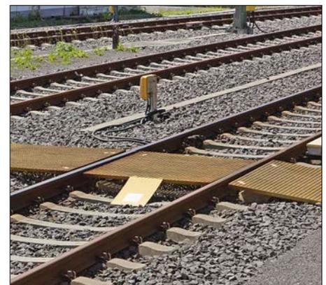
Für das Stellwerkpersonal im neuen Zweckbau sind in Brücke Gleisüberwege eingerichtet.
