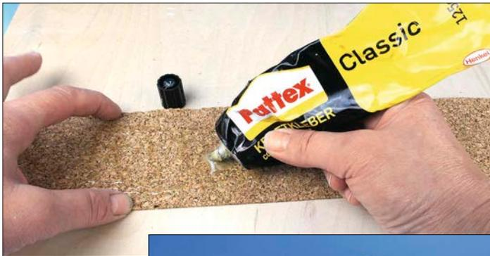
Zur Schalldämmung im Fahrbetrieb wird auf der hölzernen Trasse im Bereich der Gleise eine Schicht Kork aufgebracht. Korktapete ist preiswert als Rollenware im Baumarkt erhältlich.
