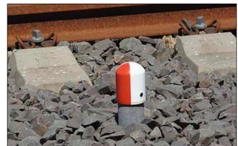
Die rot-weißen Grenzzeichen Ra 12 zeigen bei Weichen bzw. bei zusammenlaufenden Gleisen an, wie weit das Gleis besetzt werden darf.
