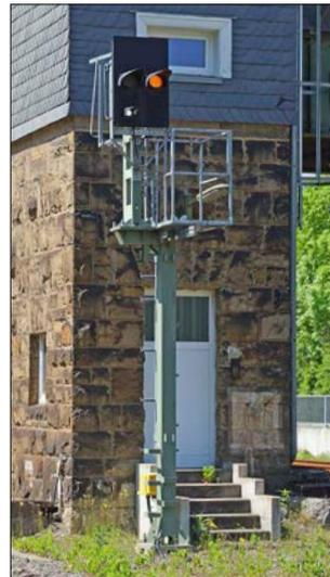
Die Hauptsignale hinter dem Stellwerk sind bei der Ausfahrt aus dem Bahnhof in Fahrtrichtung Hagen bzw. Lüdenscheid nicht gut einsehbar. Aus diesem Grunde wurden Vorsignale aufgestellt.
