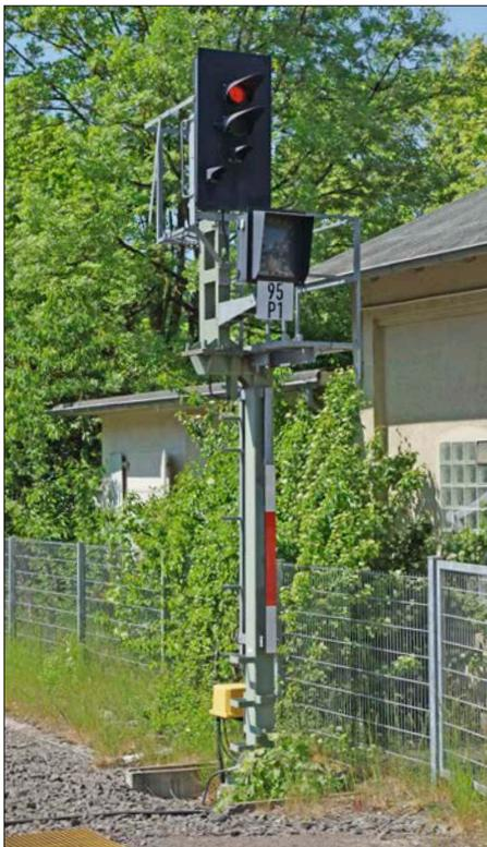
Das Ks-Ausfahrtsignal der RB52 besitzt im Original unter dem Schirm einen Zusatzanzeiger.
