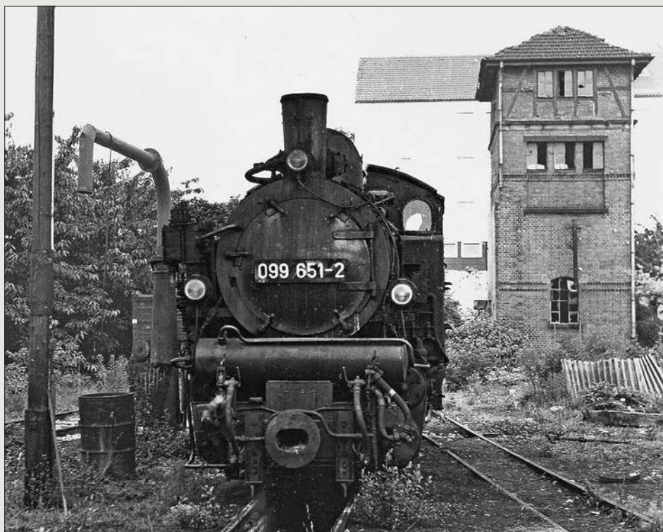
Juli 1969 in Heilbronn Süd: Der Wasserturm - hier leicht separiert und höher ausgeführt - wird zum letzten Mal gebraucht, an seinem linken Eck sieht man die Anbauspuen vom 1901 erbauten, nach 1950 abgebrochenen Lokschuppen, auf dessen Untersuchungsgrube die Lok steht. Foto: Dipl.-Ing. Herbert Stemmler
