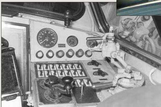
Das Führerpult der V 200 war nur mit dem Nötigsten ausgestattet (Aufnahme vom 3. Juni 1954 in V 200 002). Unten links der Fahrstufenhebel. Darüber einige Schalter und Leuchtmelder. Das große Rundinstrument ist der Tacho. Seitlich sind noch die Bremshebel zu sehen. Foto: Oesterling, Archiv Michael Meinhold
