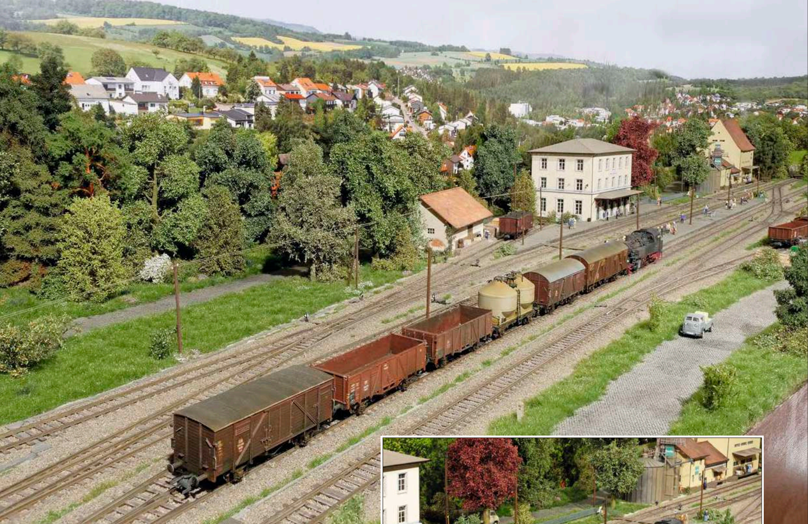
Einfahrt des Güterzuges in Heldenstein. Auf diesem Gleis werden die Güterzüge zerlegt.
