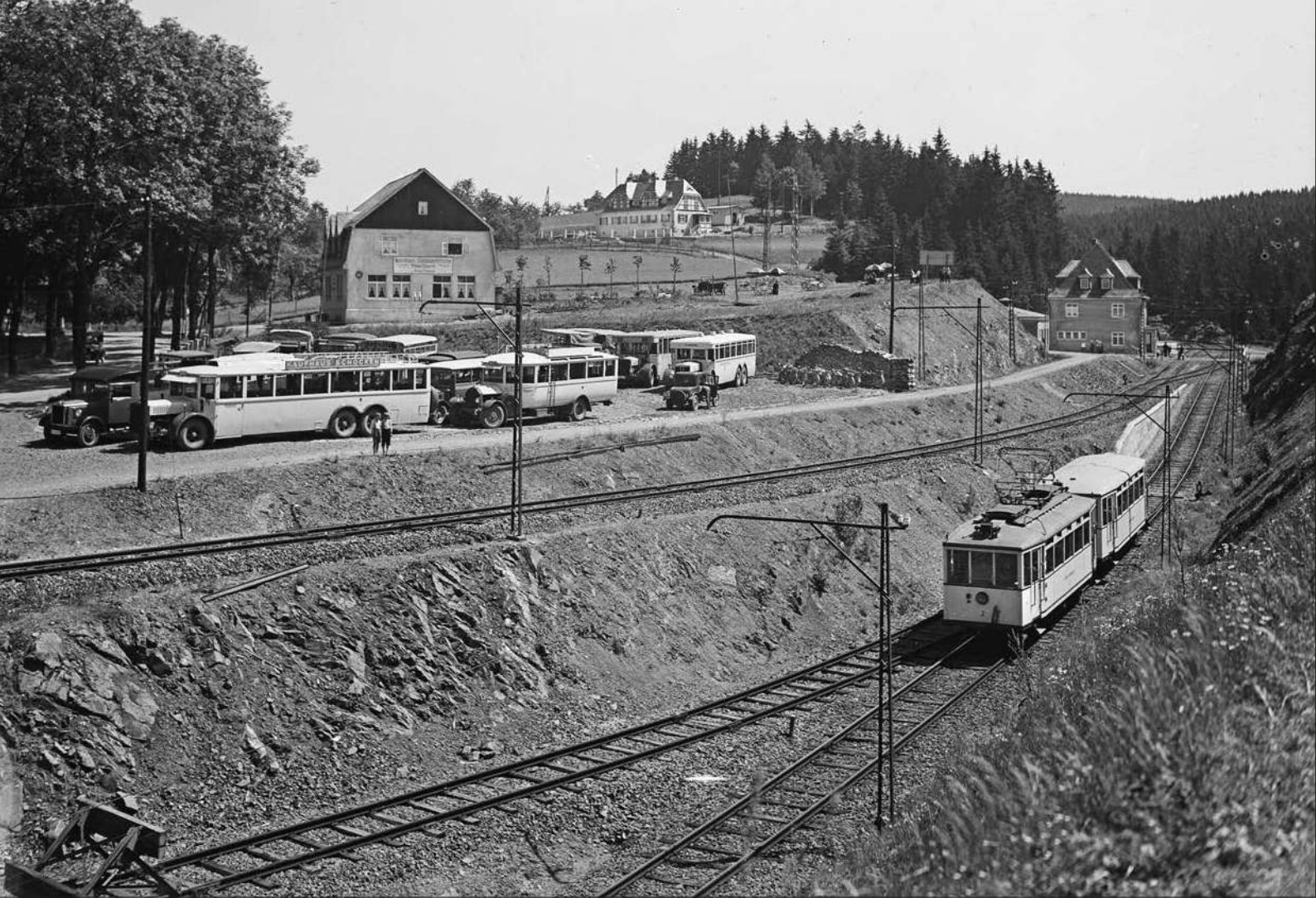
Die Aufnahme aus dem Jahr 1934 zeigt einen aus Gräfenwarth nach Saalburg ausfahrenden Zug der Schleizer Kleinbahn AG bestehend aus einem ET und Beiwagen. Vorn das Schutzgleis, oben das liegengebliebene Baugleis zur Talsperre. Für Busse und Pkws geht es in Richtung Staumauer nicht weiter.
