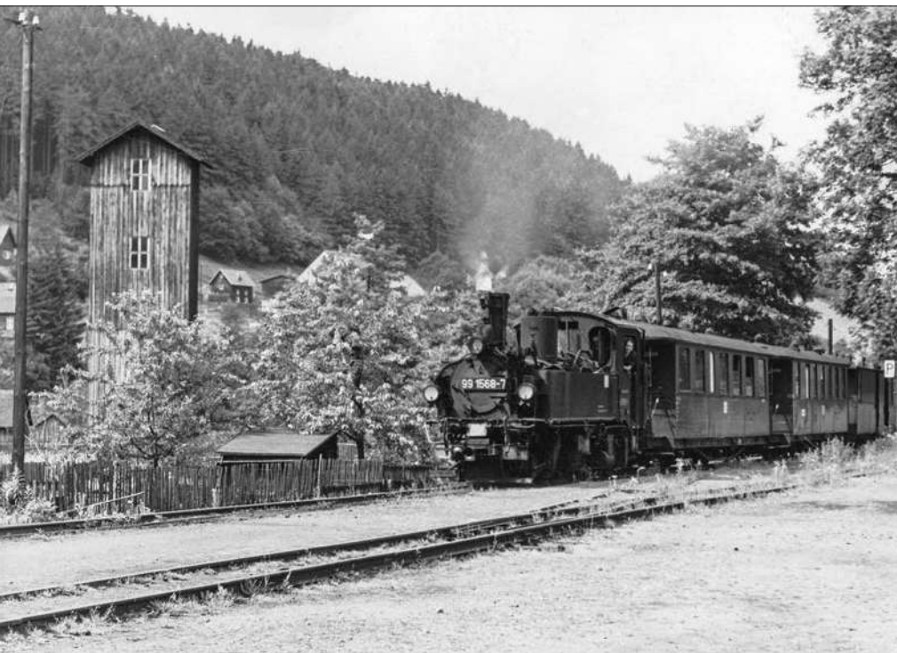
99 1568-7 erreicht von Grünstädte kommend auf dem Weg nach Rittersgrün die erste Unterwegsstation Pöhl. Dort schweifte der Blick vom Zug auf den Übungsturm der Freiwilligen Feuerwehr. Diese Situation ist die Anregung für eine Eckgestaltung einer H0e-Strecke. Im Fall Pöhl waren im Turm sogar Fensterrahmen vorhanden. Es zeigt, wie individuell dieses einzigartige Detail umgesetzt werden kann. Foto: H. Finzel / Slg. Scholz
