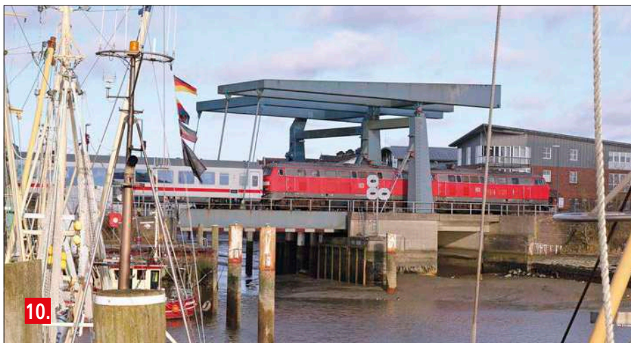
10. Bewegliche Hubbrücken oder Klappbrücken sind hierzulande eher selten, um so einfacher sollte daher diese Waagebalkenbrücke verortet werden können. Während die „führende“ 218 363 bereits seit einigen Jahren nicht betriebsfähig in Leipzig Engelsdorf steht, ist 218 381 in klassischem Blau-Beige für Railsystems RP im Einsatz. Vor wenigen Jahren donnerten sie noch in hier völlig normaler Doppelbespannung über die Klappbrücke von ... (5 Buchstaben)
