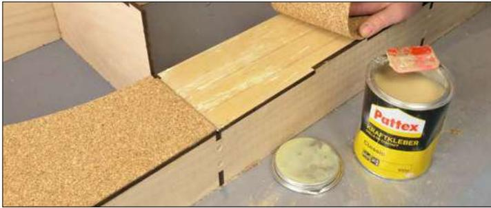
Die Gleistrassen erhalten zur klassischen Reduzierung von Rollgeräuschen im sichtbaren und verdeckten Bereich eine 2-mm-Korkschicht aus dem Baumarkt.
