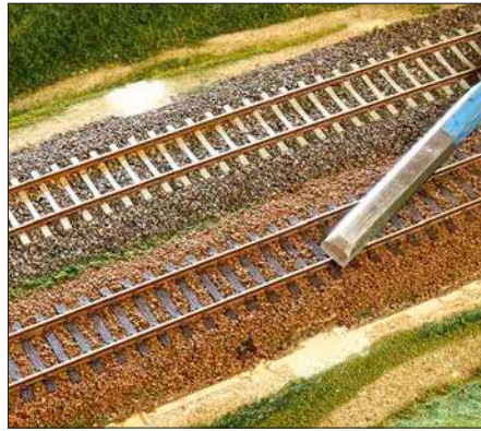
Für die neuen Maststandorte wurde der Randstreifen beseitigt und eine absolut waagerechte Fläche für das Fundament erstellt.
