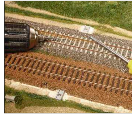
Die neuen Mastfundamente wurden probenhalber ausgelegt und die Position der Bohrung für die Befestigungsschrauben markiert.
