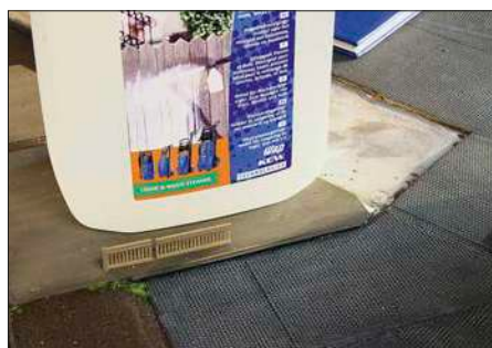
Die flächige Verklebung der Bahnsteigoberfläche fixiert man mit einem Gewicht, um eine ebene Fläche zu erhalten.
