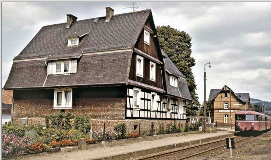
Das Eisenbahnerwohnhaus aus der anderen Richtung gesehen und der mittägliche Triebwagenkurs nach Mörlenbach, im Hintergrund das EG. Foto: wl, Slg. HM
