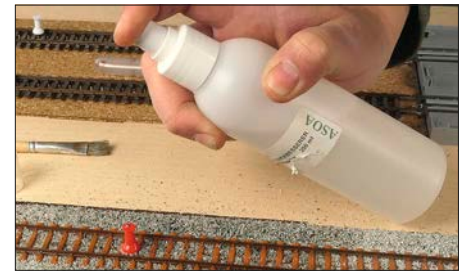
Damit der Kleber besser in den Schotter eindringt, wird Fließverbesserer aufgesprüht.
