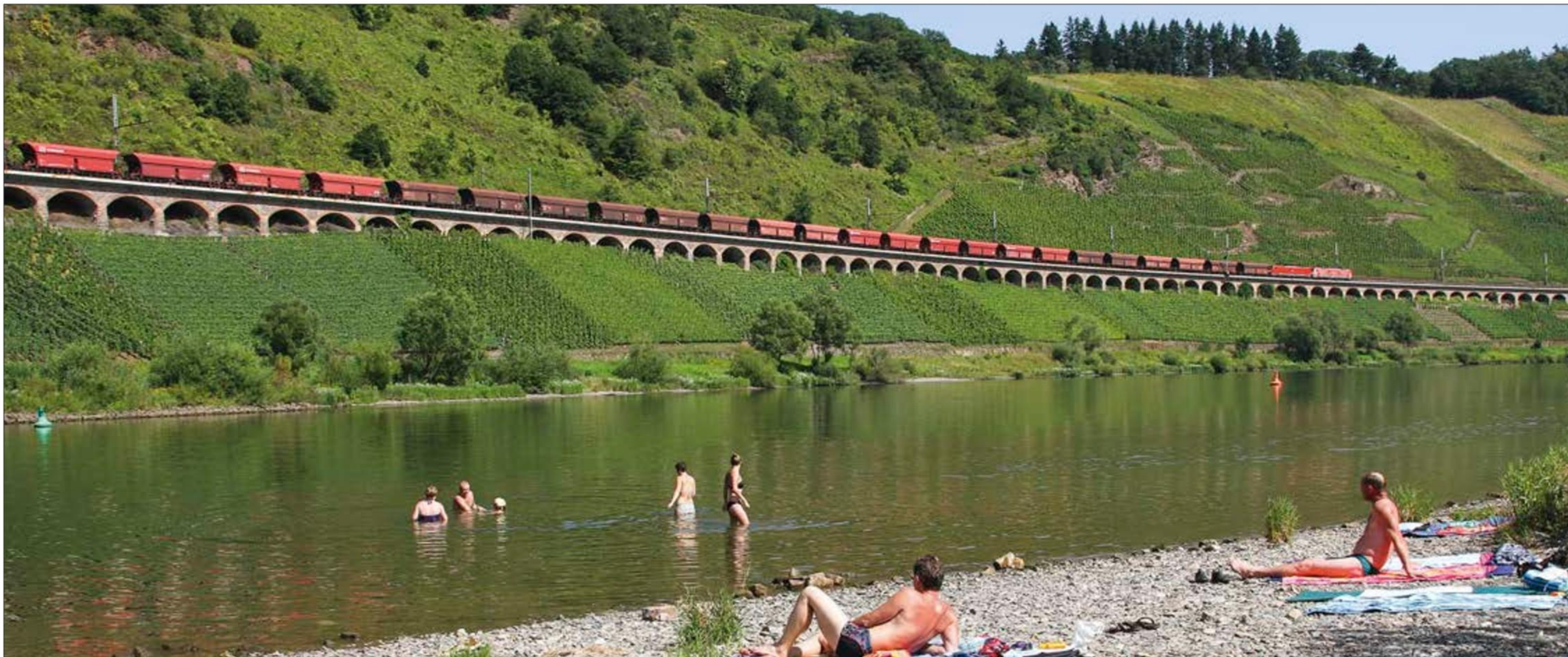
Die Pündericher Galerie ist der wohl markanteste und bekannteste Streckenabschnitt der Moselbahn. Am heißesten Tag des Sommers 2012 mit bis zu 38 Grad genießen die Urlauber das kühlende Moselwasser bei Pünderich. Über das Pündericher Hangbauwerk rollen am 19. August 2012 zwei 189er mit GM 48728 (Dillingen Hochofen Hütte–Maasvlakte Oost) Bullay entgegen. Foto: Joachim Bügel
