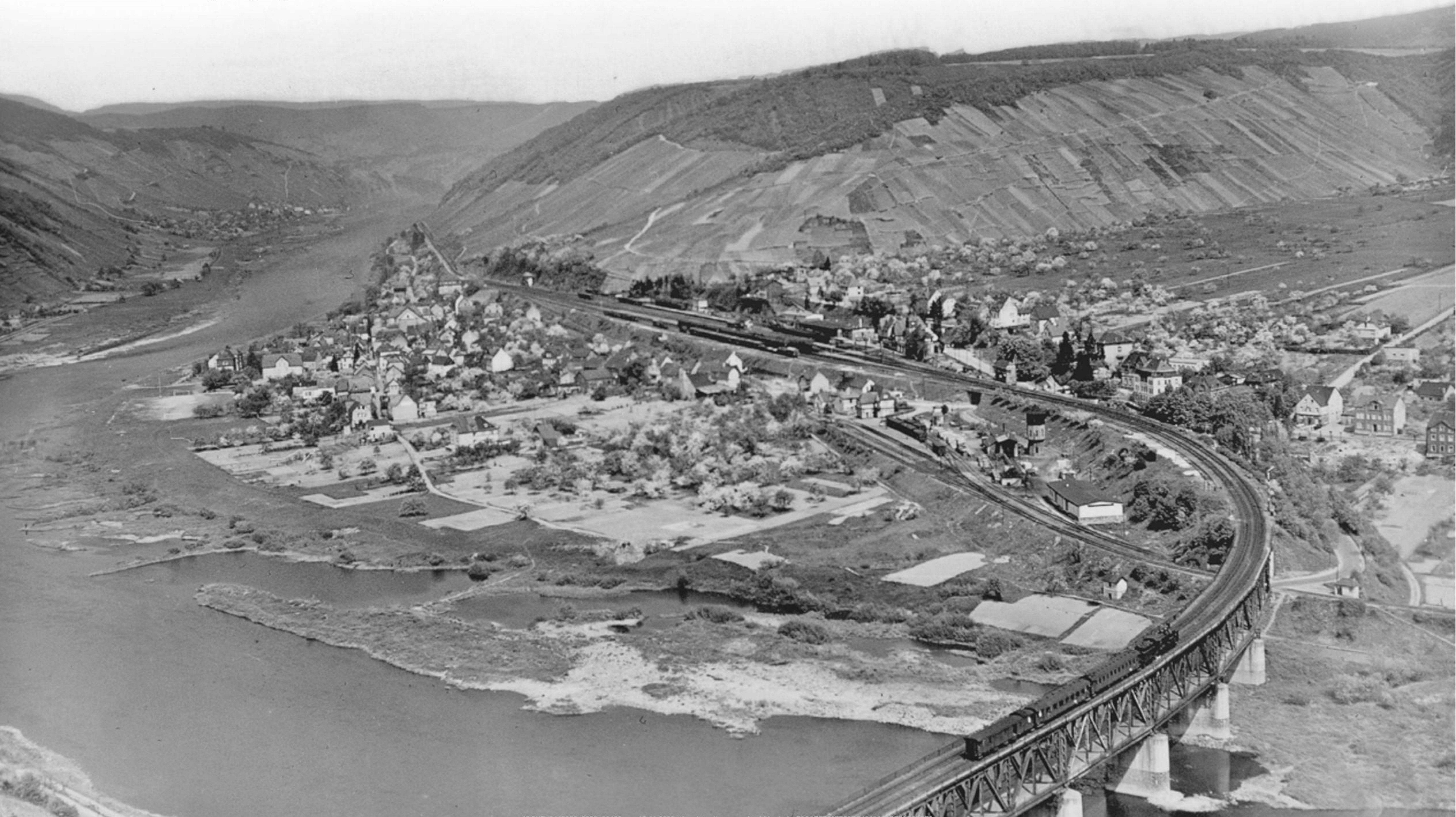
Die Luftaufnahme vermittelt ein kompaktes Bild des Kleinbahnhofes Bullay, der einer Modellumsetzung entgegenkommt. Am 26. April 1953 rollte eine BR 38 mit dem D 121 „Montan Express“ über die Bullayer Doppelbrücke der Mosel folgend Richtung Koblenz. Foto: Carl Bellingrodt, Slg. Eisenbahnstiftung
