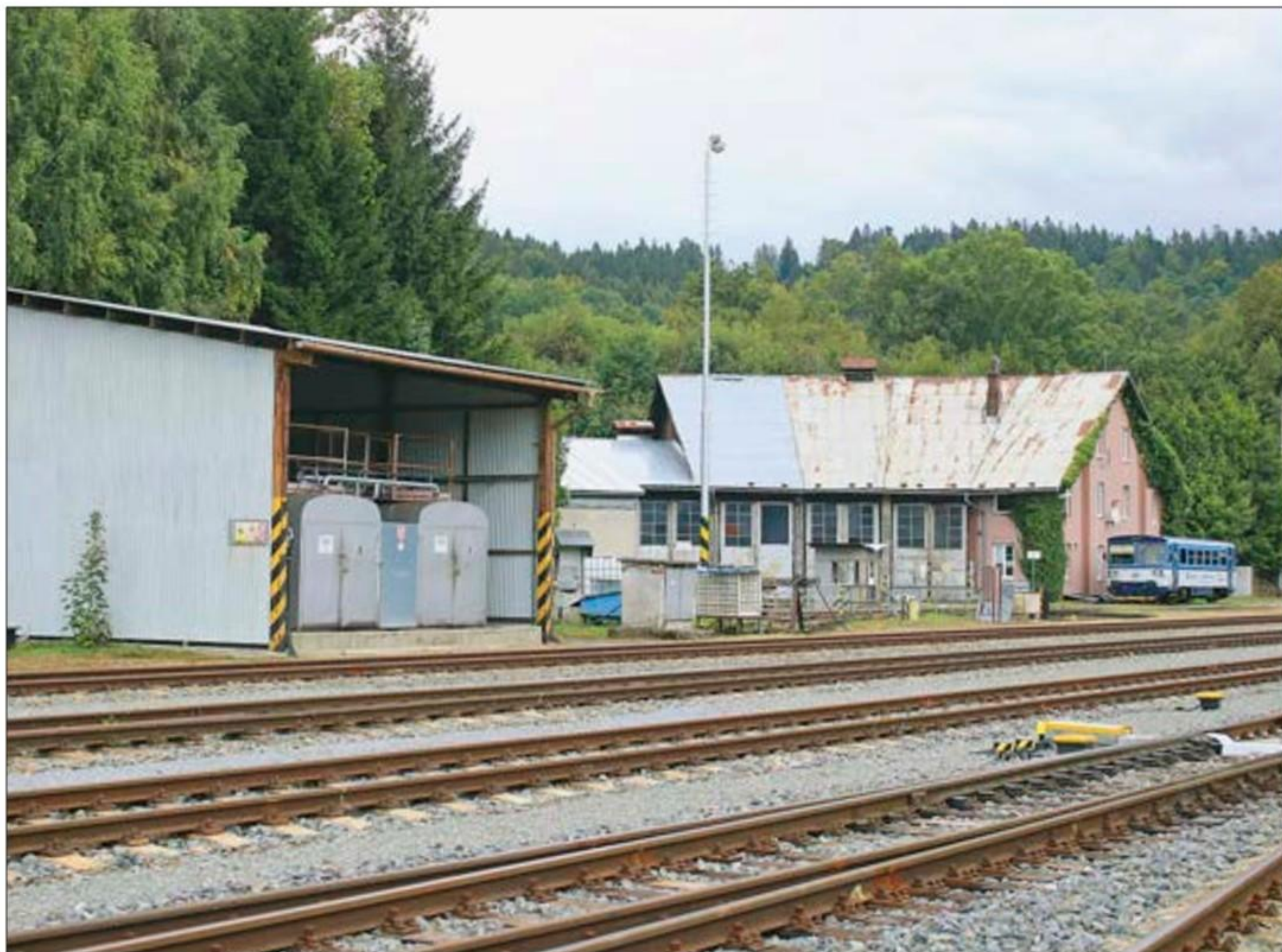
Vor der Drehscheibe befindet sich heute die Dieseltankstelle für die in Lipová-Lázne stationierten Triebwagen. Früher lag hier der Kohlenban-sen und der Kran zur Bekohlung der Loks.
