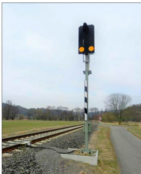
Links: Die heute gebräuchliche Bauform im kompletten DBAG Netz zeigt das Signalbild der Ex DR auf der Mastbauform der ex DB.
