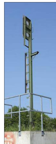
Links: Die heute gebräuchliche Bauform im kompletten DBAG Netz zeigt das Signalbild der Ex DR auf der Mastbauform der ex DB.
