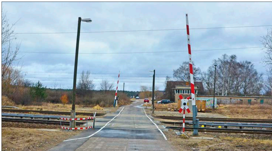
Örtlich bediente, elektrische Vollschränke, ergänzt mit WSSB-Blinklicht. Die Vollschränken weisen Reflektoren auf, da das Warnmuster nicht reflektierend ist. Bild: Bernd Stahr
