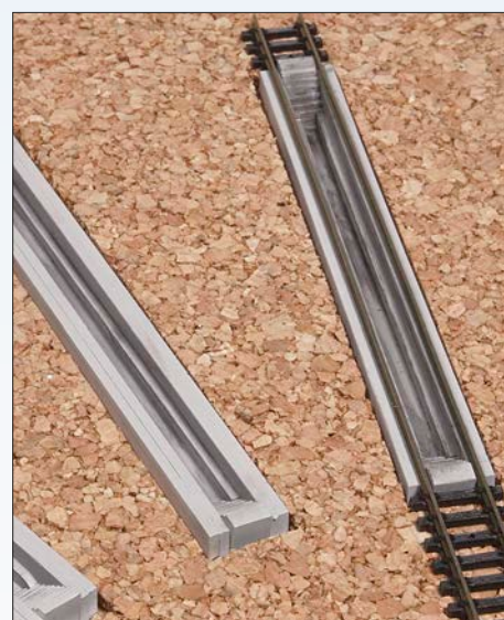
Die Schienenprofile liegen bündig auf dem Grubenrand. In die Grube wurde noch ein Absatz für das Personal eingebaut.
