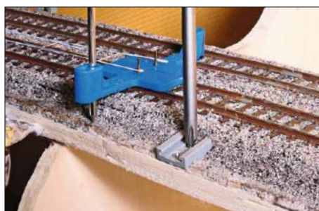
Die Masten besitzen einen Grundträger, der am besten mit der Holztrasse verschraubt wird. Die Montagelehre gibt die Position der Löcher vor.
