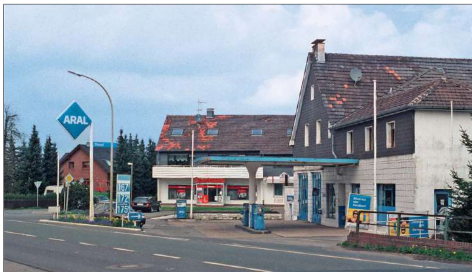
Die Aral-Tankstelle in Witten zeigt bei ihrer Aufnahme im Jahre 1999 noch alle typischen Elemente der letzten Jahrzehnte. Der Hinweis auf Diesel ist am Mast platziert, die Dieselpapfsäule steht abseits der Überdachung und die Preise hängen nicht am Mast, sondern stehen gesondert davor. Auch die Fliesen an der Hauswand stammen noch aus vergangener Epoche. Foto: Michael Blass
