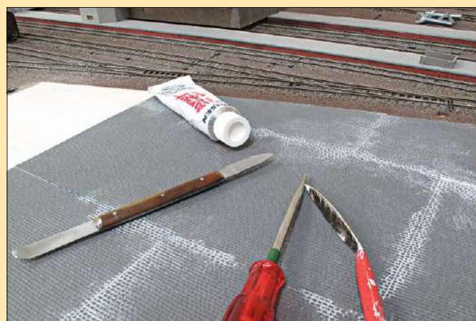
Beim Aneinandersetzen mehrerer Platten müssen die Übergänge getarnt werden, was mit einer schnelltrocknenden Spachtelmasse erfolgt, die nachgeritzt werden sollte.
