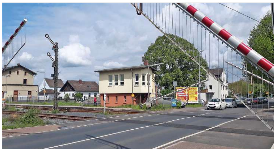
Oben: Aus vier Halbschranken besteht dieser innerörtliche Bahnübergang. Da der Schrankenwärter (auch 2019 noch) vor Ort ist, schließen sich alle Schranken gleichzeitig, denn es kann durch ihn visuell überprüft werden, ob der Bahnübergang frei ist.
