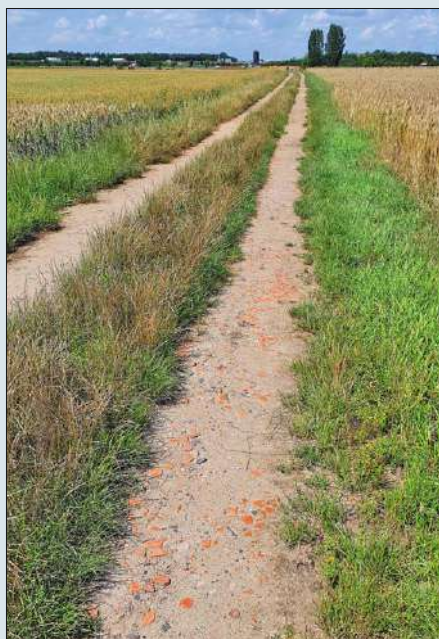
Dieser Feldweg wurde mit Ziegelbruch und anderen groben Steinen zusätzlich befestigt.
