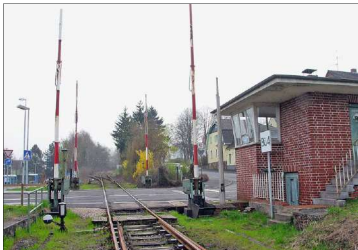
Auf dem Schienenweg nicht ganz so regelmäßig befahrene Übergänge werden auch mal mit offenliegenden Kurbeln geschlossen. Ein Wellblechdach schützt den Platz rudimentär. In vergangenen Epochen gab es diese Form auch an aktiveren Nebenstrecken recht häufig.
