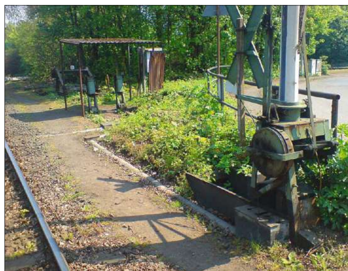
Auf dem Schienenweg nicht ganz so regelmäßig befahrene Übergänge werden auch mal mit offenliegenden Kurbeln geschlossen. Ein Wellblechdach schützt den Platz rudimentär. In vergangenen Epochen gab es diese Form auch an aktiveren Nebenstrecken recht häufig.
