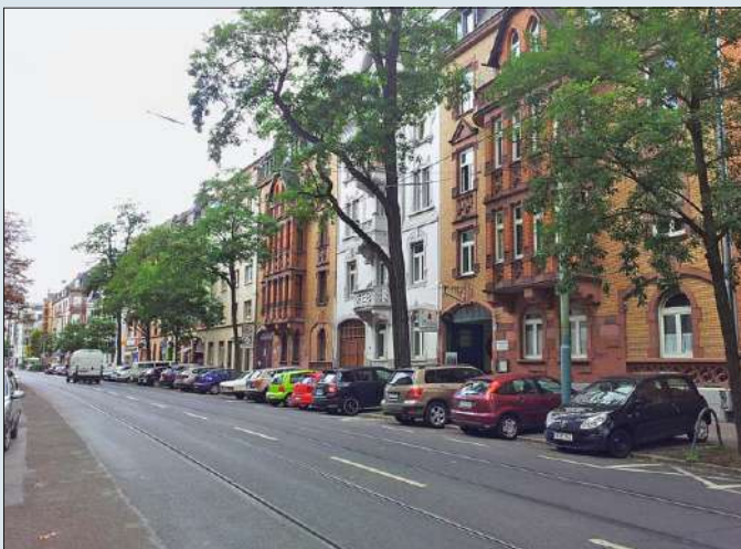
Auch oft anzutreffen sind in der Straße eingelassene Straßenbahngleise, wobei sich die mit Pflaster ausgeführte Variante zum Teil bis heute hartnäckig hält.
