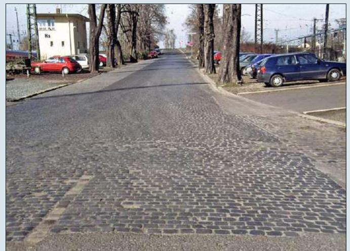
Typisch für die Blütezeit der Bahn waren Straßen aus Kopfsteinpflaster, wie hier am Bahnhof in Hanau. Besonders im Bereich von Güterbahnhöfen waren gepflasterte Flächen häufig anzutreffen.
