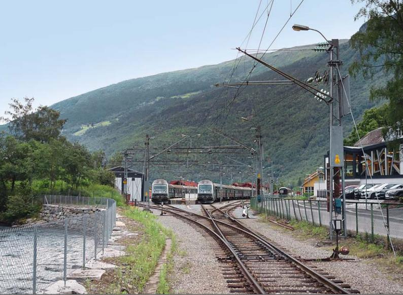
Der Bahnhof Flåm im aktuellen Zustand fotografiert von der Einfahrweiche aus. Die beiden Bahnsteiggleise sind heute Stumpfgleise. Links erkennt man den verlängerten Lokschuppen, rechts das ehemalige Empfangsgebäude. Alle Weichen verfügen über Handstellhebel.
