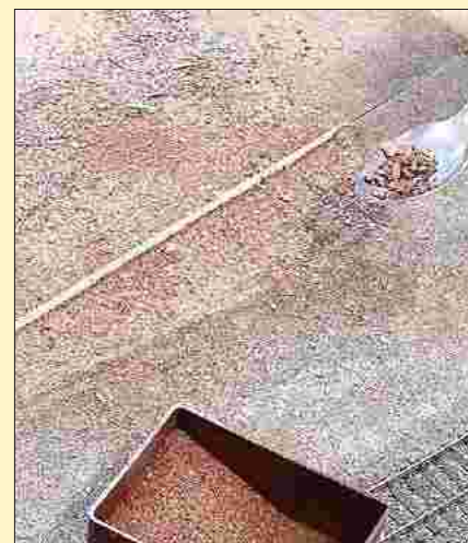
Die letzten Akzente setzen gröbere Stücke, die man gezielt mit einem kleinen Löffel sehr sparsam aufbringt
