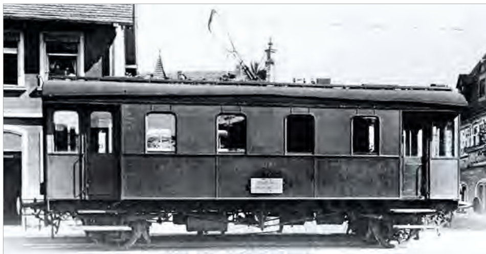
Hermann Maey hat den ET 41 kurz nach seiner Modernisierung Anfang der 1930er-Jahre am Bahnsteig in Wiesloch Stadt fotografiert. Wenn man sich den Lyrabügel wegdenkt, könnte man meinen, dies sei ein ganz normaler Personenwagen mit eingezogenen Einstiegen. Foto: Slg. Dr. Löttgers
