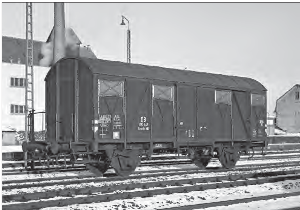
Der Gmmhs 56 290 445, aufgenommen im Januar 1958 in Volkmarsen, repräsentiert die Bauform ohne elektrische Heizleitung und mit Handbremsbühne. Foto: Reinhard Todt, Slg. Eisenbahnstiftung
