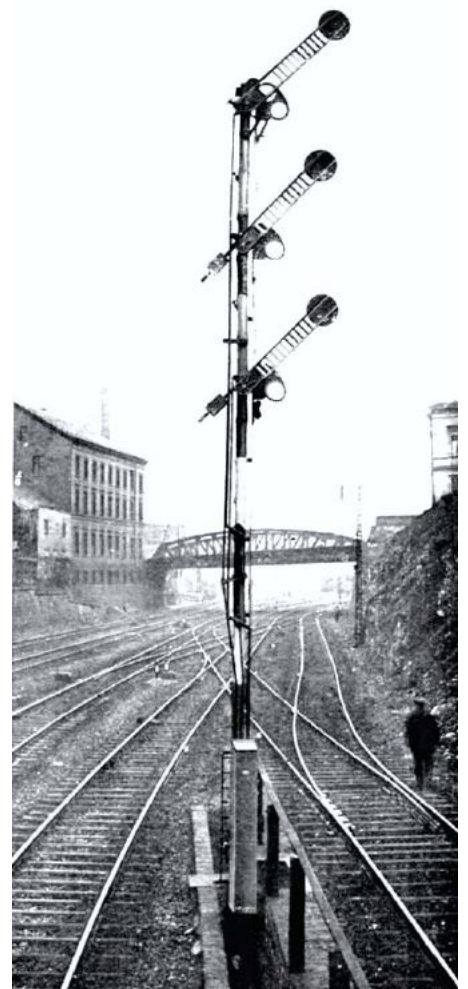
Fotos von dreiflügeligen Signalen aus der Länderbahnzeit sind selten – dies mag auch die schlechte Qualität des Bildes entschuldigen, das vermutlich ein Hauptsignal der Bauart Jüdel zeigt. Foto: Sammlung Kuhl Links: Auf der Anlage ist das preußische Hauptsignal mit seinen drei Flügeln indes ein echter Blickfang ...
