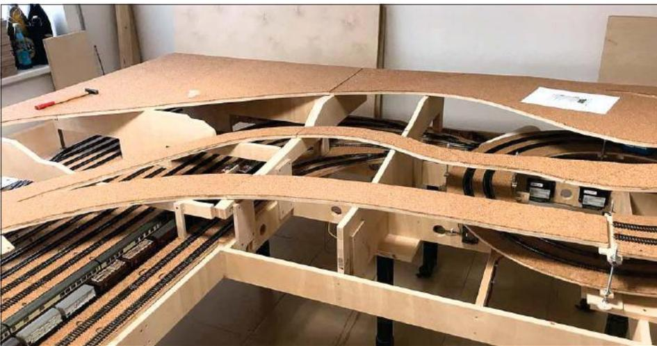
Die passend zugesägten Trassen wurden komplett mit Kork beklebt. In dieser Bauphase lassen sich noch Knicke in der Trasse für eine gleichmäßige Steigung korrigieren.
