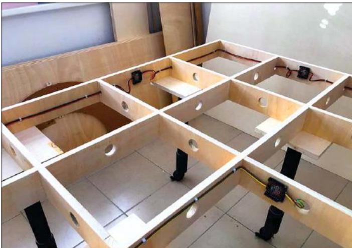
Vor dem Verlegen der Trassen werden die erforderlichen Ringleitungen verlegt. Die Fahrstromverteiler von Schönwitz sind bereits montiert.
