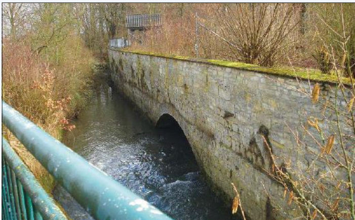
Das Bild zeigt die Vorbildsituation in Allagen. Während die Turbinen noch Strom erzeugen, sind die alten Hallen schon abgebaut.
