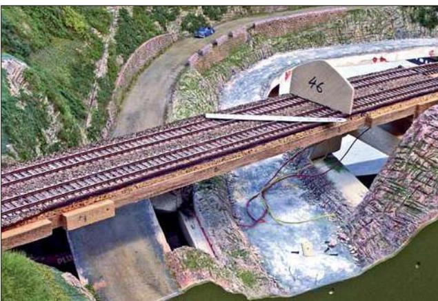
Die Brückenstruktur besteht einfach aus dem ursprünglichen Trassenbrett. Es wurde aus 12 mm dickem Meranti-Sperrholz geschnitten und ist so stabil, dass es sich bei der Spannweite nicht durchbiegt. Die Brückenverkleidung muss somit keine tragende Funktion haben und wird rein dekorativ sein. Hier sehen Sie die bereits eingeschotterte zweigleisige Strecke, die mit einem Gleisabstand von nur 46 mm (entspricht 4 m beim Vorbild und ist ein wertvoller Gewinn an Realismus!) verlegt wurde.
