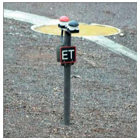
**Mit dem schwarzen Taster (ET) schaltet der Lrf die Sicherungsanlagen des Bahnüberganges ein. Fotos: Frank Schönberger**
