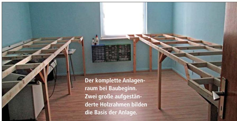
Der komplette Anlagenraum bei Baubeginn. Zwei große aufgeständerte Holzrahmen bilden die Basis der Anlage.
