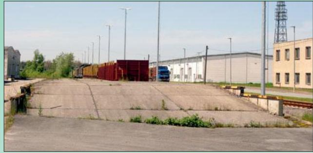
Oben: In Stendal errichtete man eine Laderampe aus Beton: hier die schräge Auffahrt; die Fugen zwischen den Betonplatten sind deutlich zu sehen.
