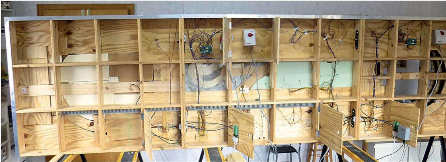
Der akkurate Rahmenbau motiviert, endlich an das eigene Projekt Hand anzulegen. Der Großteil der Verkabelung dient der Versorgung der Beleuchtung. Hinter den Türen wird die Stromversorgung installiert.
