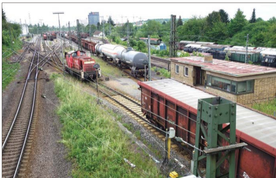
Der Ablaufberg in Kornwestheim bei Stuttgart. In dem Gebäude am Berg ist die Technik für die (automatische) Weichenstellung und die Bremsen untergebracht; ein Dienstraum für die Rangierer ist ebenfalls vorhanden.
