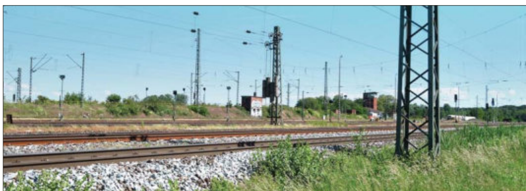
Oben: Seitenansicht des Ablaufbergs in Kranichstein bei Darmstadt. Hier sind dessen Gleise sogar elektrifiziert. In Hintergrund das Spurplanstellwerk für das Abdrücken in die Richtungs- und Bahnhofgruppen.
