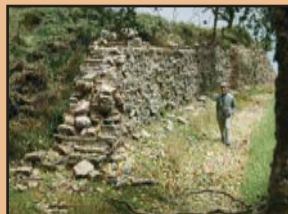
Trockenmauern H0 und 0 (1)
