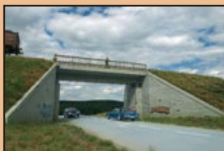
Sichtbetonunterführung für H0 und Spur 0
