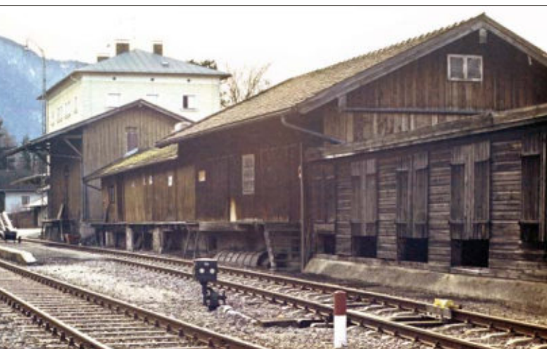
Das Bild zeigt das Ensemble der im Text erwähnten Aneinanderreihung von Güterschuppen und Lagerhallen. Das Gleis wurde durch eine Gleissperre zur Einfahrt hin gesichert. Fotos (3) Wolfgang Besenhardt
