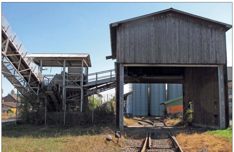
Im hölzernen Unterstand werden die Schotterwagen befüllt. Ein ganzes System von Förderbändern leitet die Bruchsteine dorthin.
