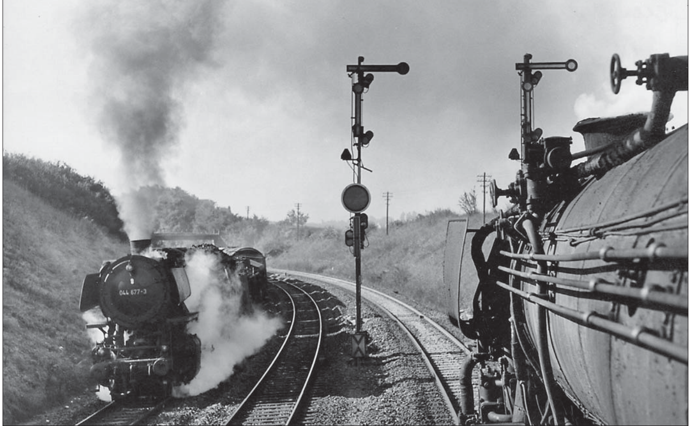
Die Einfahrtsignale von Crailsheim. Links die doppelgleisige Hauptstrecke, rechts ein einzelnes Gleis, das ebenfalls in den Bahnhof einmündet. Foto: Dipl.-Ing. Herbert Stemmler
