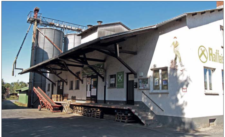
Das Landhandelsgebäude mit seinen zwei Silos hat modellgerechte Abmessungen und sowohl eine Straßenrampe als auch eine Gleisrampe.
