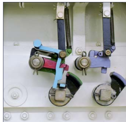
Die Wiederholungssperre im geblockten Zustand. Auch hier kann das Signal nicht auf Fahrt gestellt werden.
