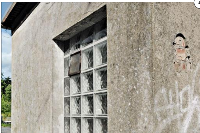
Detailfoto der linken Seite des Gebäudes von 2018
