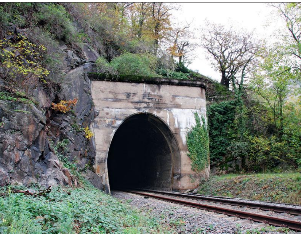
Das an sich recht unspektakulär wirkende Westportal in Betonoptik wird durch die zahlreichen Wettergraffitis mit Feuchtigkeitsflecken und Ausblühungen sowie durch den Efeubewuchs sehr malerisch und dadurch interessant. Die Umsetzung ins Modell ist gar nicht so schwer.
