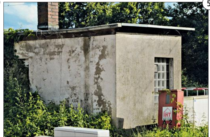
Rückseite des Gebäudes kurz vor dem Abriss in 2018
