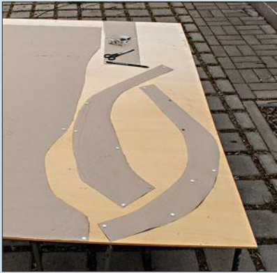
Das Zuschneiden der Trassenbretter erfolgt mithilfe von zuvor angefertigten Pappschablonen.
