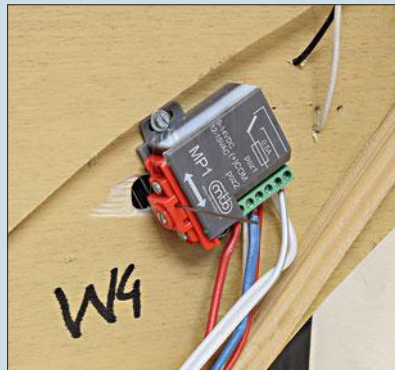
Einer der Weichenantriebe vom Typ MP1 in der Einbausituation
