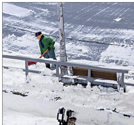
... Räumfahrzeug und ein Arbeiter mit Schaufel aufgestellt werden.
