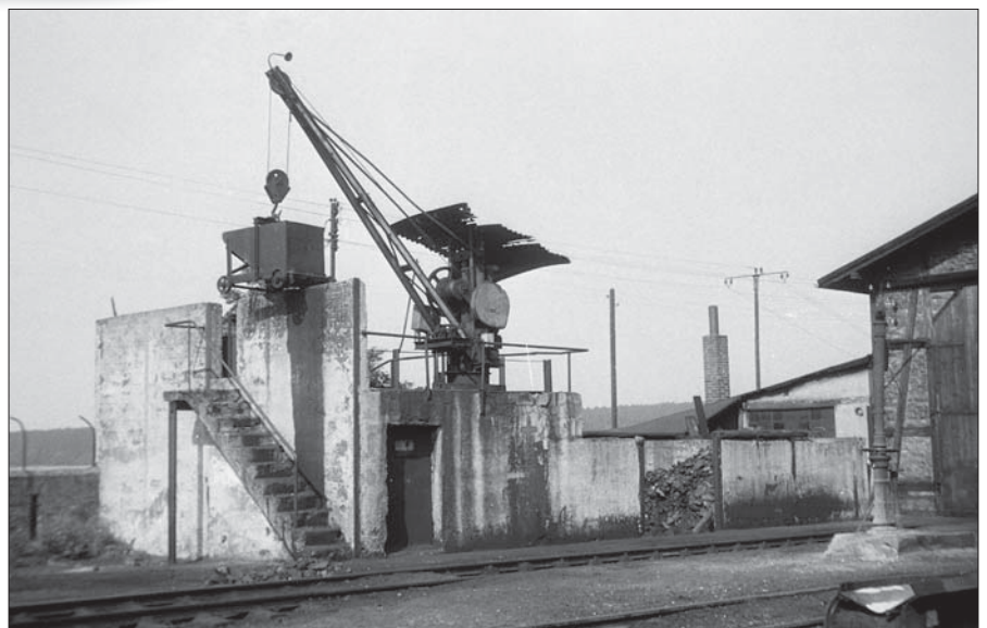
Die Bekohlung der Dampfloks erfolgt an der Bekohlungsanlage in Wellerode Wald mit einem elektrisch bedienbaren Kran und Kohlehunte. Foto: Peter Letulé, Slg. Michael Bismarck
