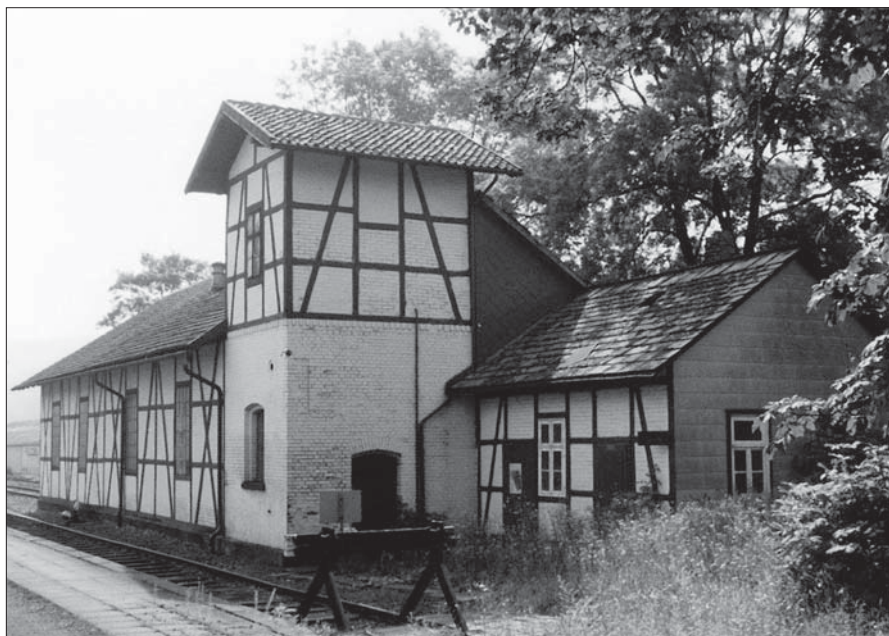
Mit den weiß getünchten Ziegelgefachen sieht der Lokschuppen mit dem Wasserturm und seinem Anbau im Zustand von 1987 recht ansprechend aus und reizt zum Nachbauen.
