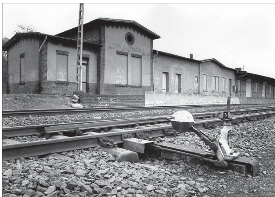
Das Blomberger Empfangsgebäude und auch der Güterschuppen hinterließen in den 1980er-Jahren einen heruntergekommenen Eindruck. Vorn die zum Umsetzen benötigte Weiche 5.
