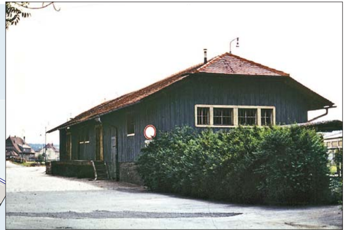
Der schlichte Volkacher Güterschuppen von der Straßenseite mit Laderampe und zwei Schuppentoren.
