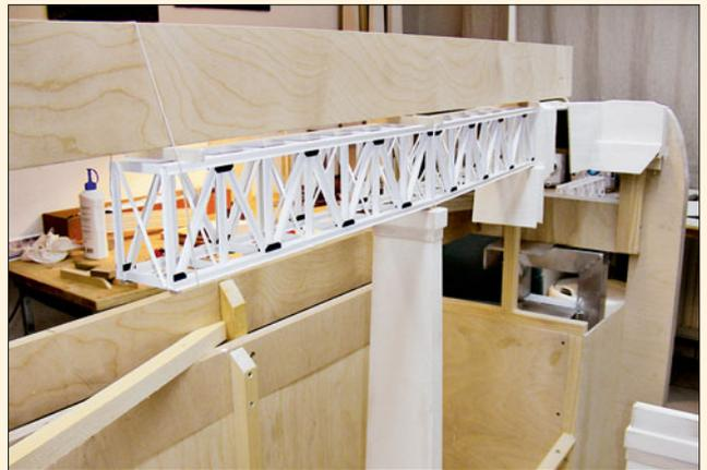
Ein Balkenprofil aus Holz oder Stahl gewährleistet eine gerade Linie zwischen den Enden der Brücke. Damit jeder Pfeiler und jeder Pfeilersockel die richtige Höhe bekommt, wird die Konstruktion mit Gummibändern am Balkenprofil fixiert.
