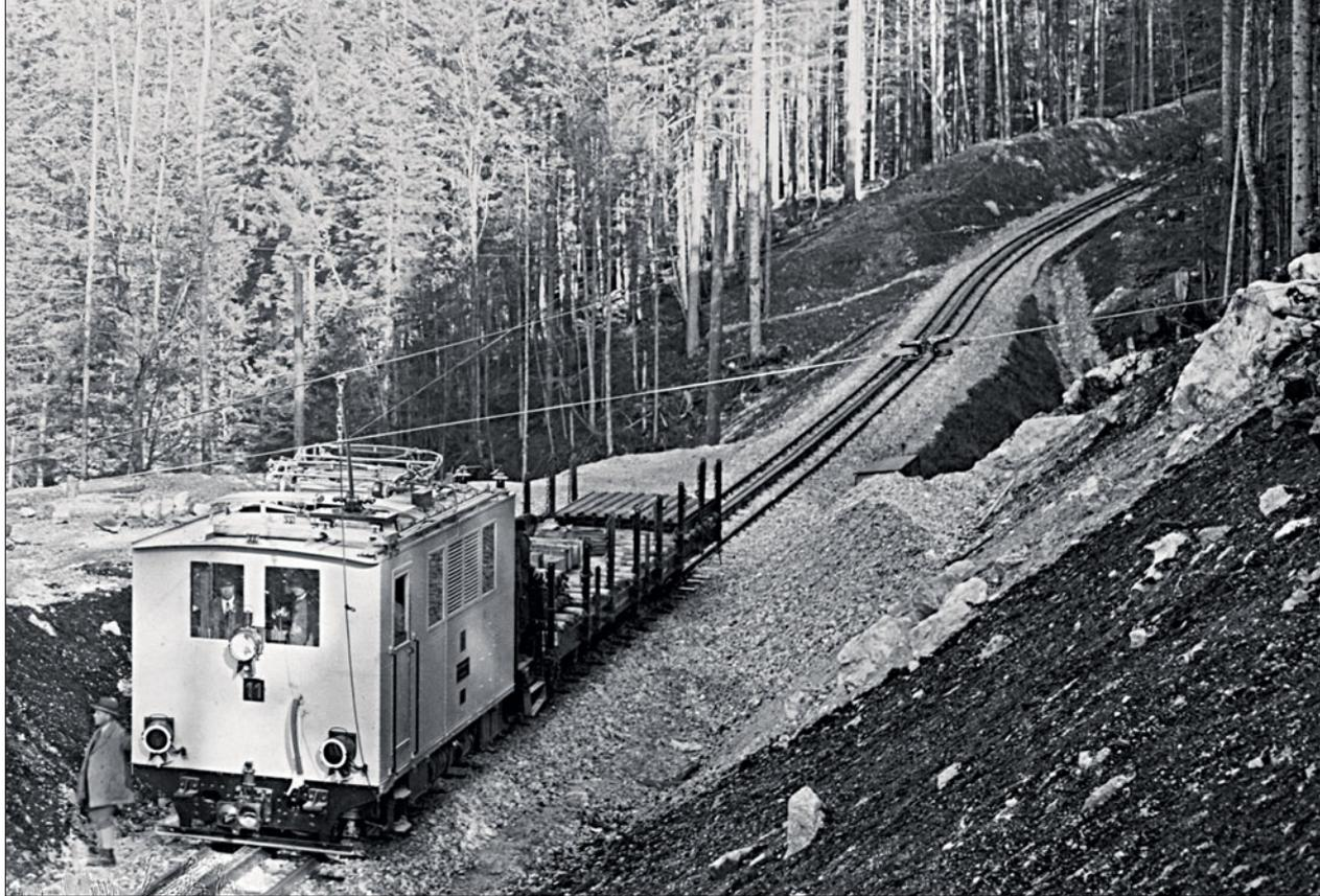
nummern 4260 bis 4267. Im Unterschied zur Tallok, die über einen normalen Scherenstromabnehmer mit einem Schleifstück verfügt, haben sie im Hinblick auf die Tunnelfahrten besonders flach bauende Stromabnehmer mit zwei Schleifstücken. Zusätzlich waren auf beiden Seiten noch Eiskratzer montiert, von denen später der bergseitige abgenommen wurde.
