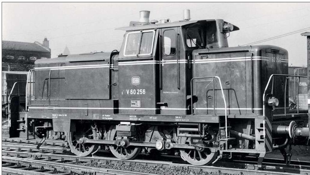
**Blick auf den kurzen Vorbau von V 60 256 (Bw Ffm-Griesheim). Hier waren Kraftstoffvorrat, Luftbehälter und Batterie untergebracht. Rechts: Am 26.7.61 stand V 60 1003 in Mannheim Hbf. Sie hat einen größeren Kraftstoffvorrat von 1500 l. Fotos: Helmut Oesterling**
