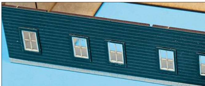
Abschließend werden die Fenster von außen mit einer sogenannten Bekleidung versehen.
