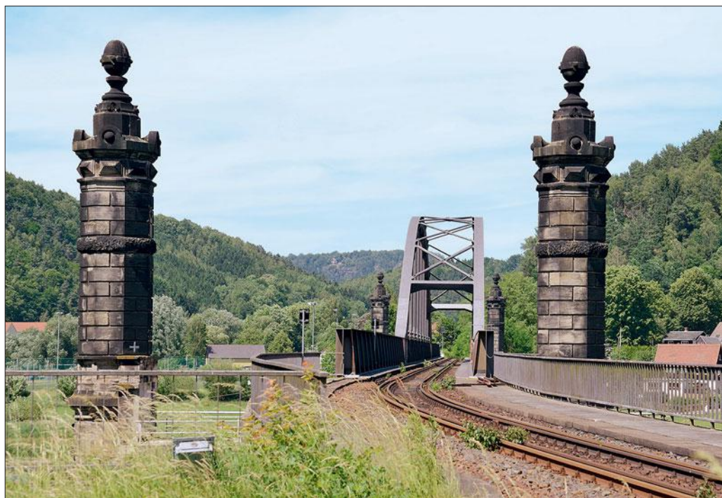
Der an die Carolabrücke anschließende Gleisbogen führt in den Bad Schandauer Bahnhof.
