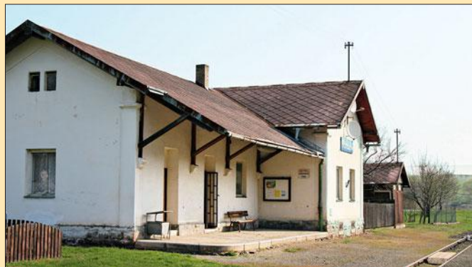
Das Empfangsgebäude ist ein typischer Standardbau österreichischer Nebenbahnen mit überdachtem Wartebereich und einem separaten Abort-Gebäude im Hintergrund.
