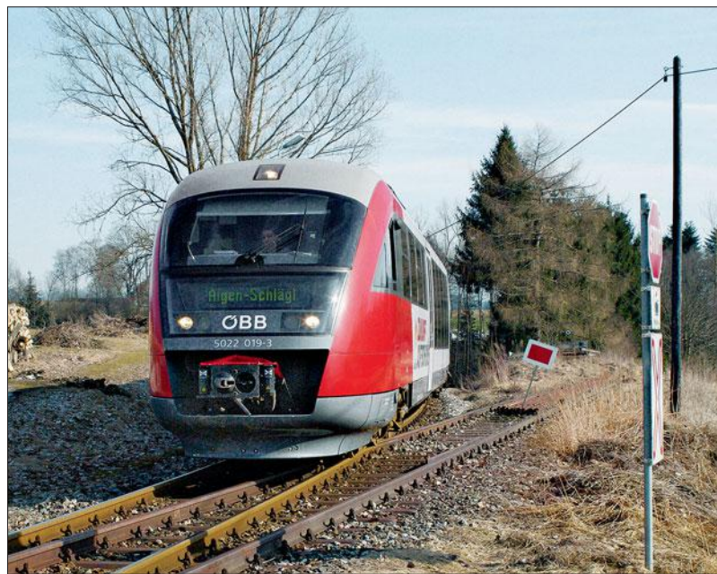
Ein Desiro passiert die Schutzweiche in der Bahnhofseinfahrt. Rechts das steigende Gleis für „entlaufende“ Wagen, das noch in den Epochen III und IV angesichts des Güterverkehrs notwendig war.
