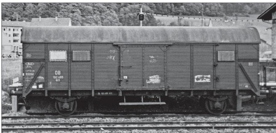
Bei der Ausrüstung mit neuen Lade- und Lüftungsklappen gab es diverse Anordnungsmöglichkeiten. Der Gl 11 192 465, aufgenommen im Mai 1958 in Lörrach, hatte im mittleren Bereich links eine Ladeklappe und rechts und links Lüftungsöffnungen erhalten; dies war eine der häufigeren Varianten. Außerdem hatte der ungebremste Wagen neue Laufwerke mit Austauschbauart-Achshaltern bekommen.
