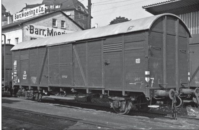
Der 1963 in Stuttgart Hgbf fotografierte Gltmrs 28 200 084 war ein genieteter Glr Dresden mit weicher Abfederung, den die DB mit 20-t-Radsätzen ausgestattet hatte.
