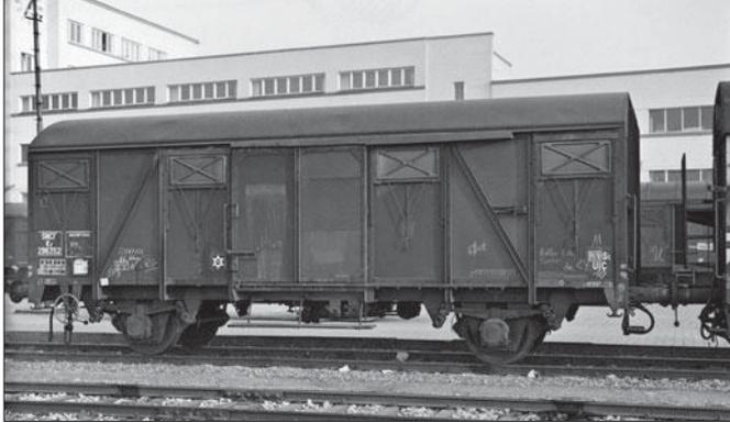
Ebenfalls nach UIC-Zeichnungen gebaut war der 1963 in Stuttgart Hgbf fotografierte Kv (v = Feststellbremse) 296352. Er besaß aber Plattenwände, geschlossene Federböcke und Isotherm-Gleitachslager. Hingegen entsprach der 1960 aufgenommene Kf (f = Spindelbremse) 338 487 der älteren Bauform noch mit herkömmlichen Gleitachslagern. Foto Reinhard Todt, Slg. Eisenbahnstiftung
