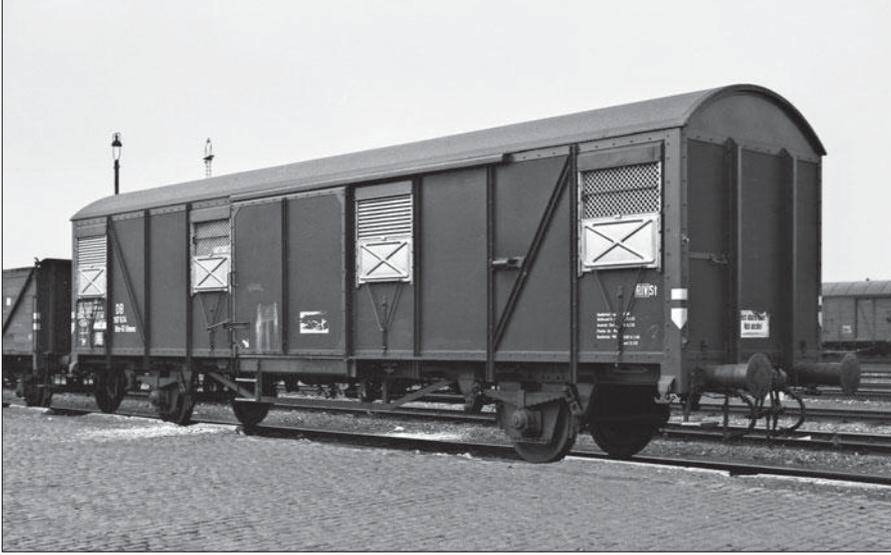
dardbauart. Beschafft wurden allerdings zunächst Sonderausführungen: 1961/62 eine Serie von 500 Wagen mit Schiebedach – Gvmm(dh)s – und 1963 100 Gvmmts mit Stirnwandtüren. Von 1965 bis 1970 folgten dann 5.450 Gbs. Alle diese Wagen erhielten nun gesickte Seitenwände. Die Gbs und Hbcs wurden als UIC-Einheitswagen eingestuft und mit RIV St gekennzeichnet.
