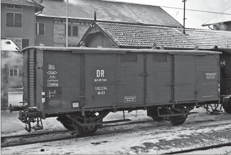
Den 1908 gebauten in München Ost beheimateten Gh 03 102 234 hatte das AW Freimann am 11.1.54 untersucht. Er durfte nur für den Stückgutverkehr auf den Strecken der ED München eingesetzt werden. Der Wagen besaß für den Einsatz in Reisezügen eine Westinghouse-Personenzugbremse und Dampfheizleitung. *Foto Fritz Willke*
