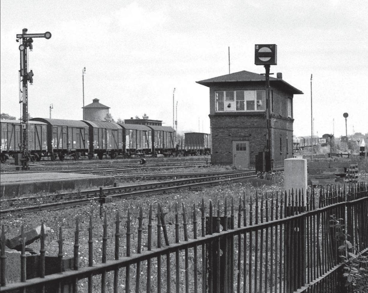
Ablaufbetrieb im Bf Soest im Sommer 1965: In der Wagengruppe, die 50 832 gerade über den Berg drückte, waren am Ende fünf unterschiedliche Gs zu sehen, unmittelbar vor der Lok ein in den EUROP-Park eingestellter „Standard C“ der SNCF. Auch die beiden anschließenden DB-Wagen waren im EUROP-Park: ein Gmms 60 und ein Gmhs 35. Es folgten zwei Wagen in UIC-Abmessungen, deren Trittstufen unter den Türen sie als nicht-deutsche Wagen ausweisen.
