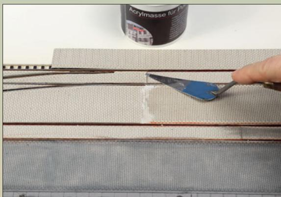
Dies muss in jedem Fall vermieden werden; daher habe ich die Ränder des Kartonstreifens im Bereich der Klein-eisen ungefähr auf die Hälfte ihrer Dicke abgeschliffen. Das geht mit Schleifpapier recht schnell; mit einer Modellbausäge lassen sich die Ränder auch exakt auf Maß bringen. Beim Einkleben des Basisstreifens sollte man zudem die Flanken des Kartons mit einem schmalen Griffel fest auf die Klein-eisen drücken.
