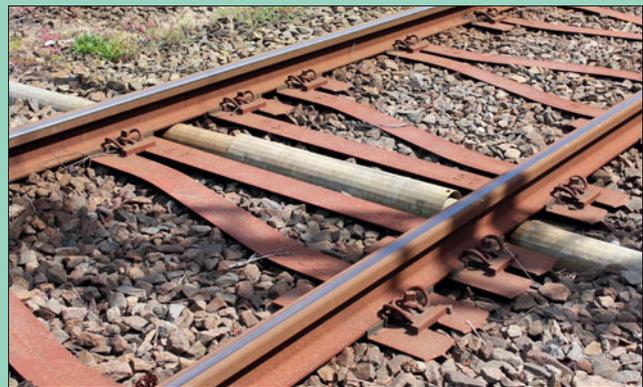
Schwellen mit einem geraden Schenkel, die beim Vorbild zum Übergang auf herkömmliche Querschwellen Verwendung finden.
