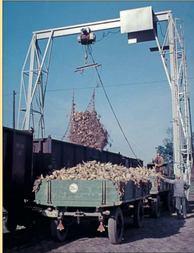
Dieser Kran ganz speziell zur Verladung von Hackfrüchten war auch auf regelspurigen Bahnhöfen im Einsatz. Er bestand aus Stahlträgern, die als Fachwerkkonstruktion über die erforderliche Stabilität und Tragkraft verfügten. Der Kran überspannte das Gleis und einen der Fahrzeugbreite von Straßenfahrzeugen entsprechenden Sektor der Ladestraße. Das Ladegut wurde in Netzbehältern über eine Laufkatze verschwenkt und in die offenen Waggons der Bahn entleert.
