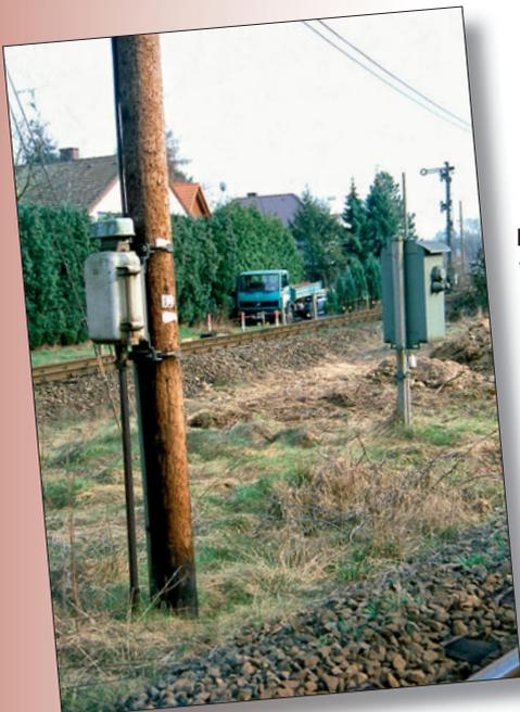
**In Bahnhöfen, vor Tunneln oder Brücken ist es erforderlich, die Telegraphenleitung als Erdkabel weiterzuführen. Dazu werden sie an einem Endmast in einem Rohr nach unten geführt und verlaufen dann unterirdisch weiter.**
