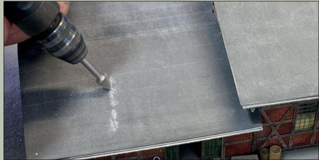
Der Grund für die Dachausbesserung ist ein Riss in der alten Dachhaut. Man kann ihn mit einem Kegelfräser vorsichtig in das Kunststoffdach einfräsen und danach die Fräserränder mit dem Bastelmesser entgraten.
