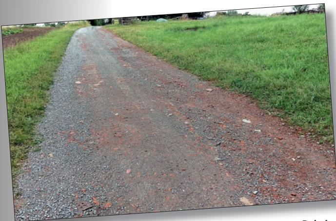
Bei vielen Feldwegen wird Material verwendet, welches gerade günstig und in Mengen zur Verfügung steht. Im obigen Beispiel kam Sandstein und Basaltbruch zum Einsatz. Im anderen Beispiel wurden alte Pflastersteine (Bauschutt) verfüllt.
