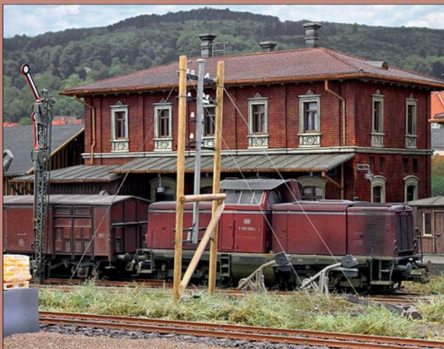
Ein doppelter Endmast im Bahnhof: Er hat mehrere Traversen und einen dickeren, vertikalen Kanal. Die beiden Telegrafmasten sind zudem noch versteift und verspannt worden.
