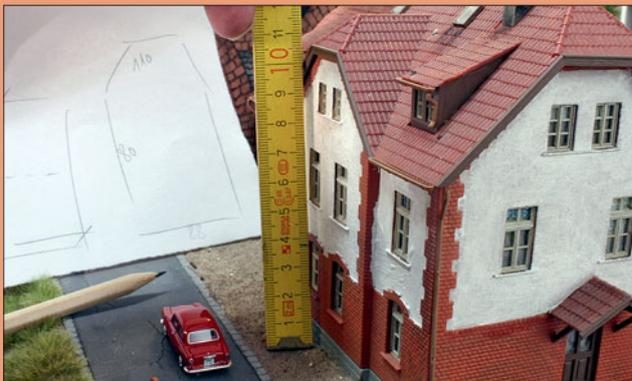
Für das notwendige Gerüst gilt es, die Grundmaße und vor allem die passenden Höhen zu ermitteln. Es sollte in etwa nach den einzelnen Stockwerken ausgerichtet sein. Vorsprünge und Giebel müssen ebenso mit einbezogen werden wie die unebene Grundfläche.
