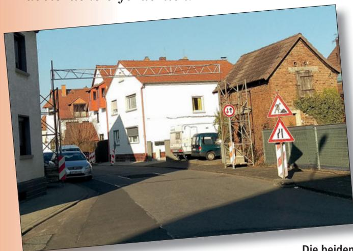
Die beiden Gerüste und ein versteifter Querträger dienen den beiden Hausbaustellen als Kabelbrücke für ein dickes Stromkabel vom Hauptverteilerkasten zu den Baustromverteilern.
