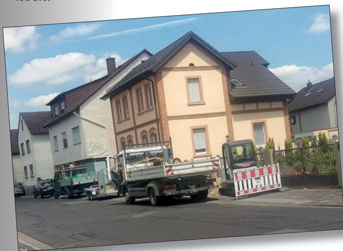
Was früher Muskelarbeit war, erledigt heute oft ein Kleinbagger. Immer dabei: LKWs mit Werkzeug, Material und Absperrvorrichtungen. Nettes Detail oben: die Wasserleitung wird abgesperrt, das Wasser läuft in der Rinne ab. Scheinbar wurden hier schon mehrfach Reparaturen vorgenommen, was man an den Asphaltausbesserungen sieht.
