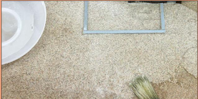
Der Sandbrei reagiert mit dem trockenen Untergrund etwas zäh, es entstehen zunächst raue Ränder. Mit einem in Wasser getauchten Flachpinsel lassen sich die Übergänge weich ausstreichen und damit zur Umgebung hin egalisieren.
