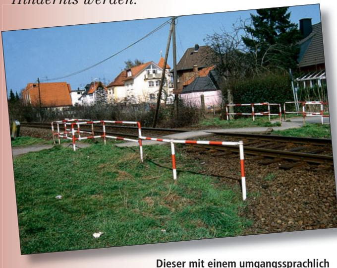
Dieser mit einem umgangssprachlich als „Drängelgitter“ bezeichneten Konstrukt gesicherter Wegeübergang soll verhindern, dass Fußgänger und Fahrradfahrer ungestüm und ohne auf Züge zu achten die Gleise überqueren.
