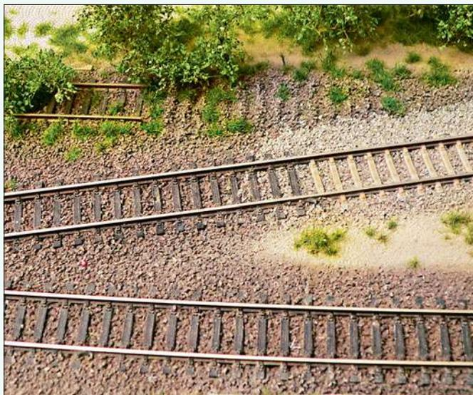
Dort, wo es früher eine Weiche gab, beginnt ein neuer, frisch eingeschotterter Gleisabschnitt mit Betonschwellen. Bemerkenswertes Detail: Dass hier eine Weiche lag, sieht man auch an den Quervertiefungen im Altschotter.
