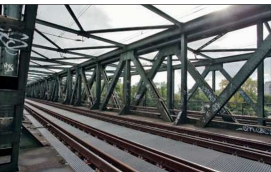
Die Frankfurter Main-Neckar-Brücke beim Vorbild. Aufgrund der Konstruktion hängen die Fahrleitungen sehr niedrig, sodass hier die Geschwindigkeit auf lediglich 40 km/h beschränkt ist.
