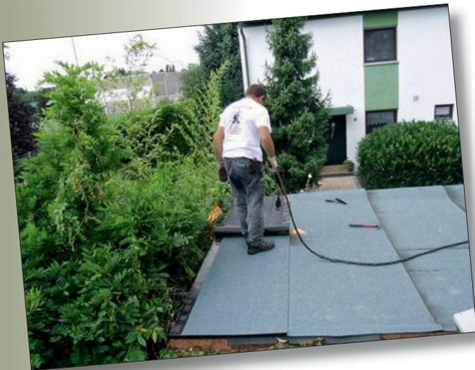
Bei Flachdachsaniierungen werden neue Bahnen von Dachpappe aufgeklebt. Dies erfolgt mit Hitze, indem nach bestimmten Vorarbeiten die Abschlussbahnen mit der Teerseite nach unten durch die Wärme verschweißt werden.
