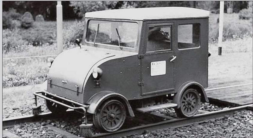
Der KlV 04-3111, ein Typ C, läuft im Jahre 1958 bei der BD Kassel. In Trendelburg hat das Gefährt mit seinen putzigen Schienenbesen kurz Pause.
