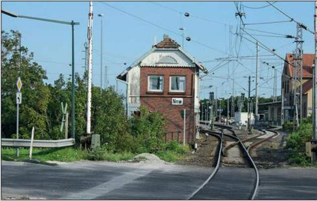
Blick auf das mechanische Stellwerk Norden-Norddeich-West (Nnw) aus Richtung Norddeich-Mole. Von diesem Stellwerk aus wird auch die Schrankenanlage für die Straße bedient.
