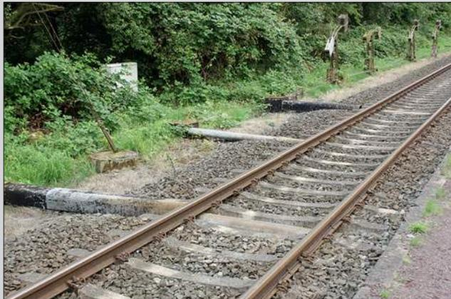
Bei den eingeschossigen Stellwerksräumen werden die Drahtzugleitungen meist erst auf der den Gleisanlagen gegenüberliegenden Seite abgelenkt und dort als Hauptleitungsverlauf geführt. Hier stehen auch Spannwerke.
