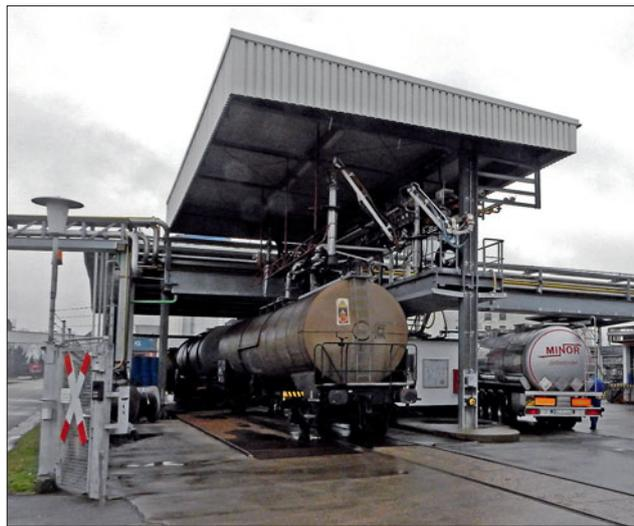
Hier werden sowohl Tankwagen als auch Tankcluster befüllt. In der Regel erfolgt dies nicht direkt vom Schiff, sondern über Zwischentanks, da die Liegezeiten teuer sind.
