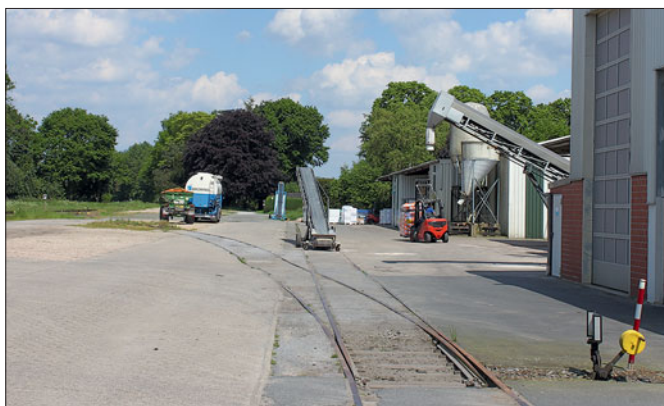
Dieser Landhandelsbetrieb in Veldhausen an der Bentheimer Eisenbahn besitzt ein langes Ladegleis, das in die Ladestraße eingelassen ist. Über einen Verbindungsbogen besteht Anschluss zum Bahnhofsgleis.
