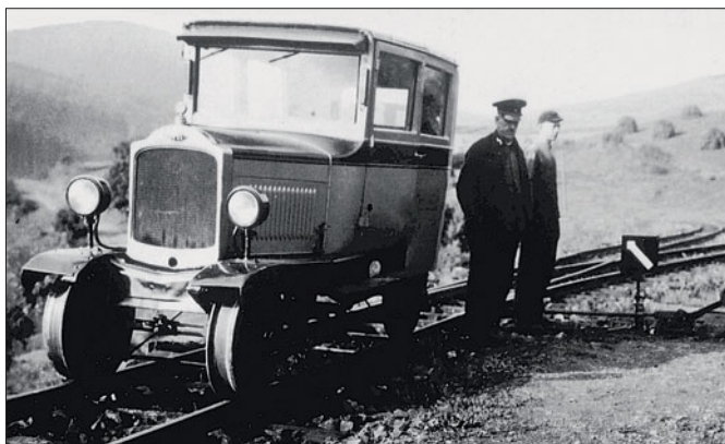
Ein Opel P 4 auf 750 mm Spurweite! Der Bahnverwalter der Kleinbahn Steinhelle–Medebach benutzte ihn für seine Inspektionsfahrten. Die beiden Bilder zeigen das Fahrzeug bei einem Halt in der oberen Spitzkehre der malerischen 750-mm-Strecke zwischen Küstelberg und Wisinghausen und vor der Gastwirtschaft Schmidt in Wiemeringhausen, die zugleich auch als Agentur diente. Foto: WVG Medebach
