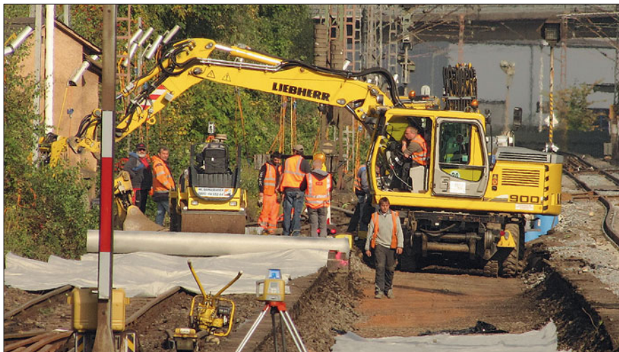
An manchen Stellen wurde bei dieser Gelegenheit das komplette Gleisbett erneuert – dazu kam der Grabenlöffel des Liebherr A 900 zum Einsatz. Fotos: Dr. Löttgers
