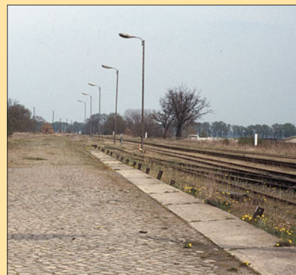
Hier dienen Betonblöcke als Kantschutz für die gepflasterte Ladestraße.
