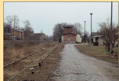
An der Ladestraßenpflasterung von Uckrow dienen Schienenprofile als Abweiser.
