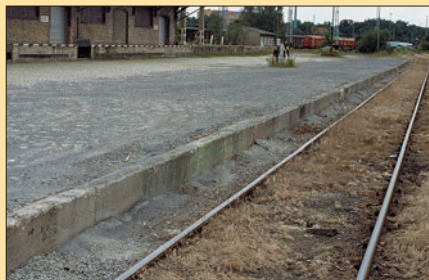
Hier dienen Betonblöcke als Kantschutz für die gepflasterte Ladestraße.
