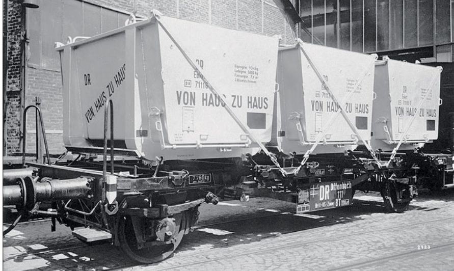
Ein BTs 50 mit drei offenen Großbehältern auf dem Werksgelände der SEAG – die Beschriftung im Jahre 1952 immer noch mit „DR, Offenbach“ und „Brit.-US-Zone“. Die Aufnahme eines unbeladenen Schwesterfahrzeugs im Bild unten macht deutlich, wie die Behälter auf dem Wagen befestigt werden.
