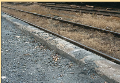
Im Bahnhof Eberswalde ist als Radabweiser eine massive Betonkante vorhanden.
