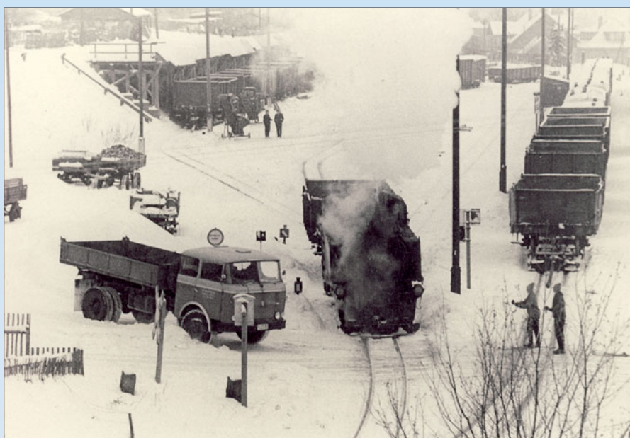
Im Januar 1967 hat es nach der offiziellen Einstellung der Splittverladung am 25.12.1966 noch eine Verladung an der Rampe gegeben. Ein Sieben-Wagen-Zug steht dort bereit, weitere leere Rollwagen auf dem Streckengleis. Der Lkw brachte neben weiteren Fahrzeugen die letzten Splittladungen zur Schüttrampe. Danach war es für immer vorbei. Foto: Slg. Häupel
