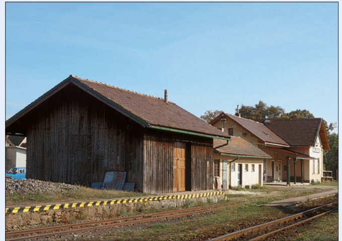
Diese tschechische Rampe hat als Kantenschutz ein Schienenprofil erhalten. Als „Schmalspurrampe“ zeigt sie eine nur geringe Höhe.
