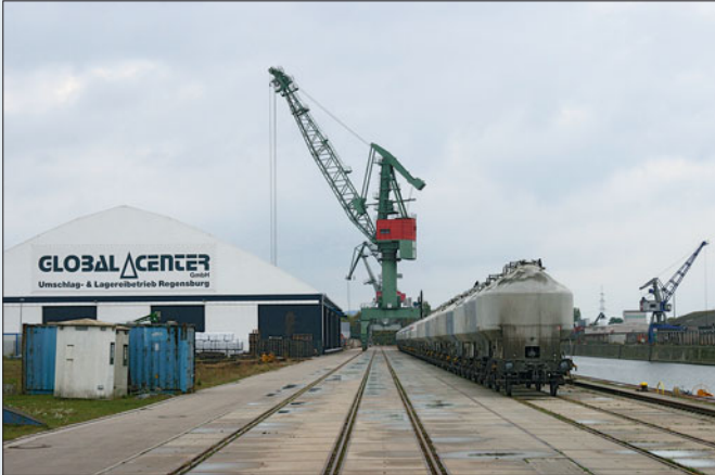
Die Firma Cemex lud bis 2014 im Hafen Regensburg Zement aus Ucs-Wagen direkt in Lkws um. Im Einsatz waren Ucs-Ganzzüge.
