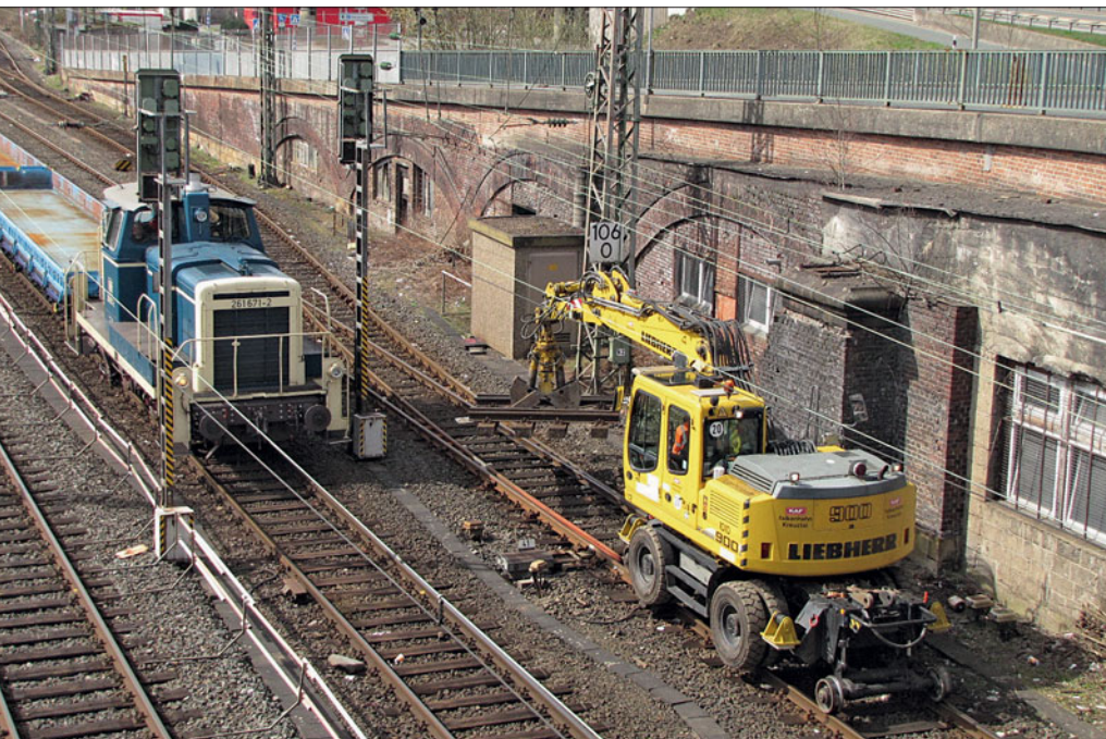
Die massive Konstruktion der Schienenführung beim Atlas-Kran ist hier gut zu erkennen. Unten: Im Rahmen von Gleiserneuerungsmaßnahmen im nördlichen Teil des Bahnhofs Siegen transportiert ein Liebherr A 900 ausgebaute Schienenstücke ab.
